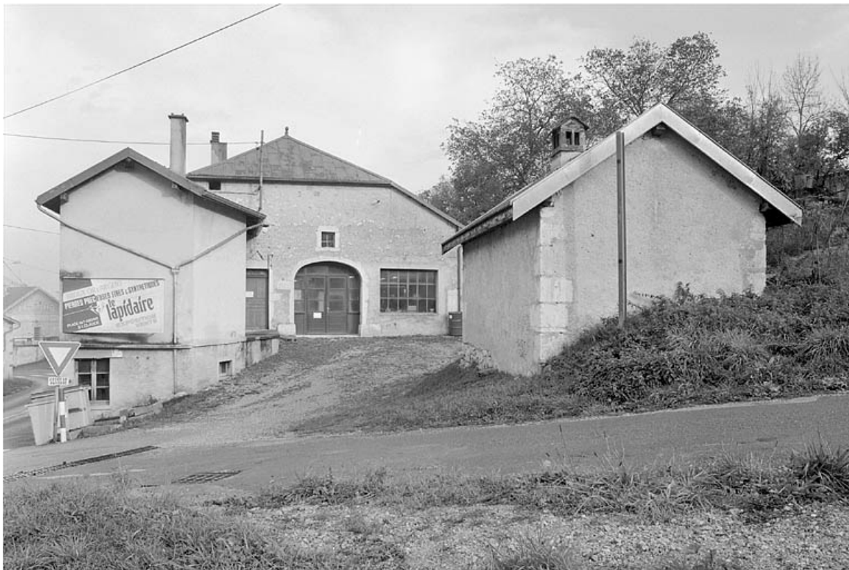
Ferme au hameau de l'Essard transformée en atelier. 39, Villard-Saint-Sauveur
