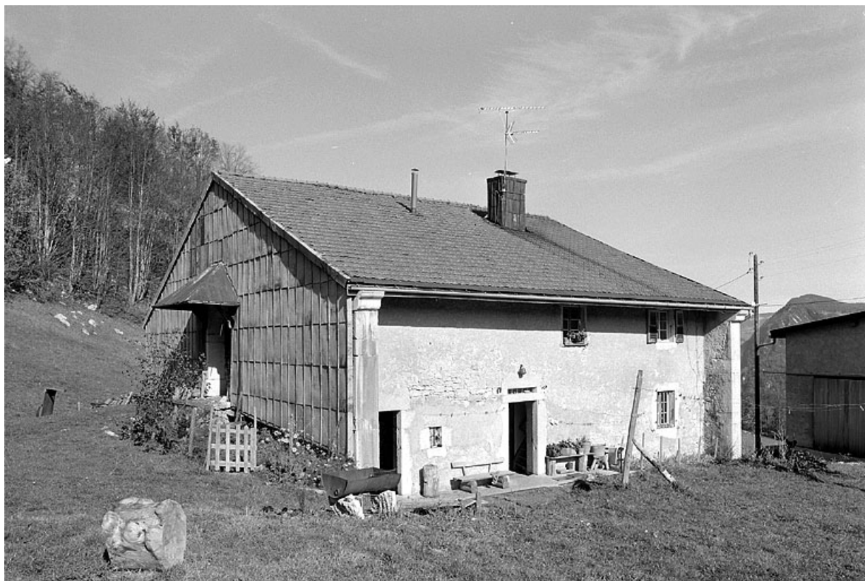
La ferme de la Rapine. 39, Villard-Saint-Sauveur
