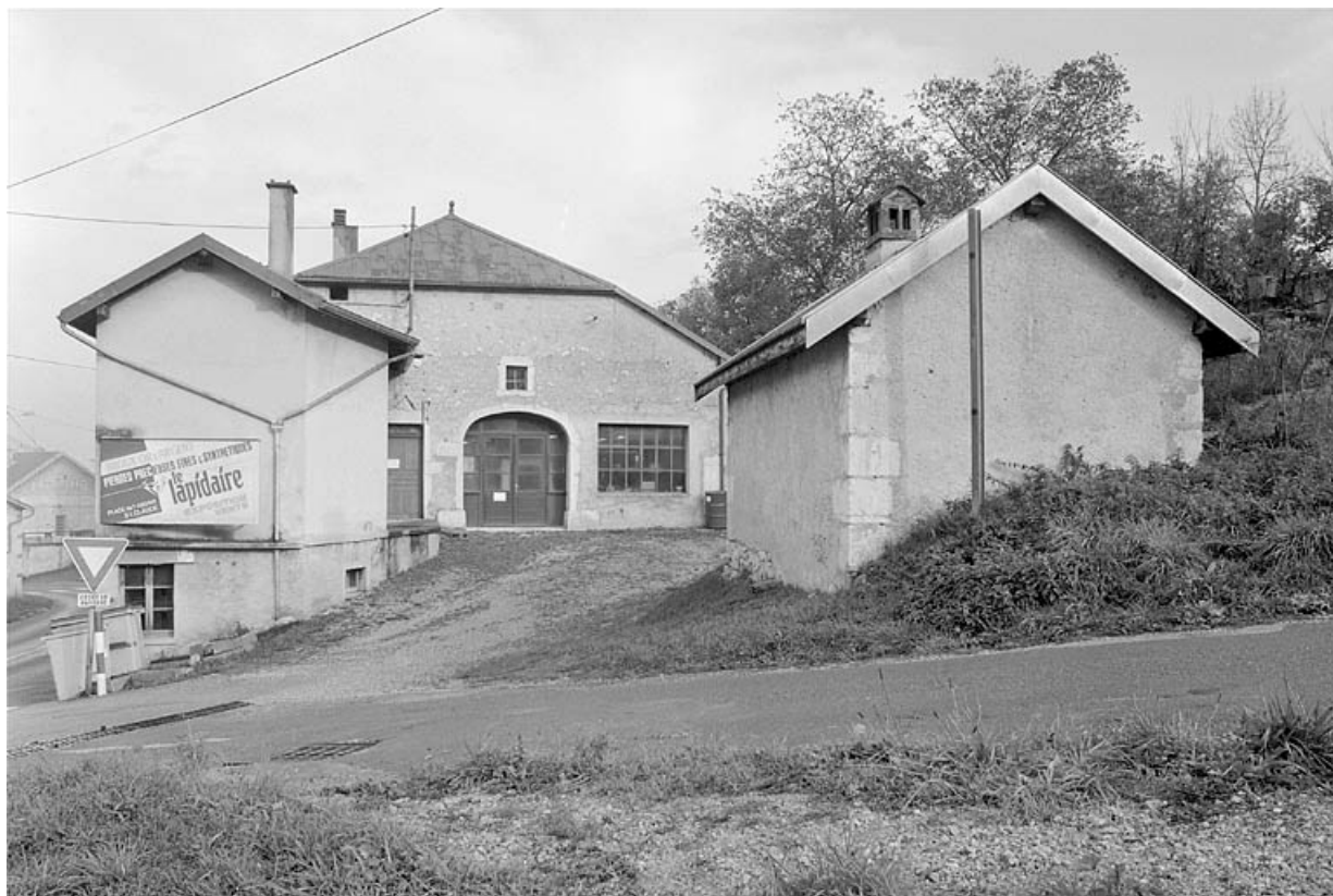
Ferme au hameau de l'Essard transformée en atelier.
