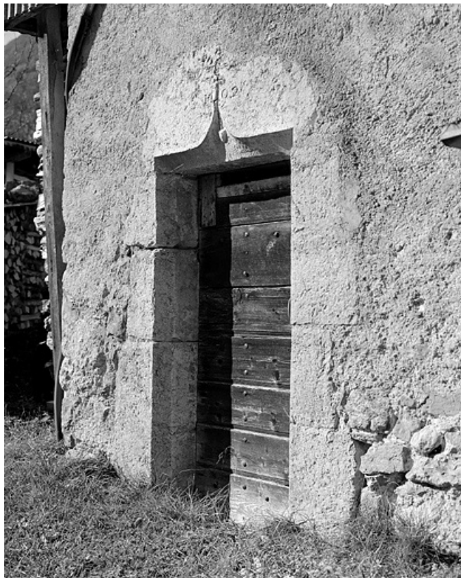
Porte avec accolade. 39, Villard-Saint-Sauveur
