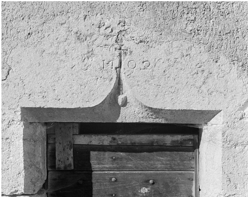
Accolade du 16e siècle, remployée au 18e siècle, au hameau du Maréchet. 39, Villard-Saint-Sauveur
