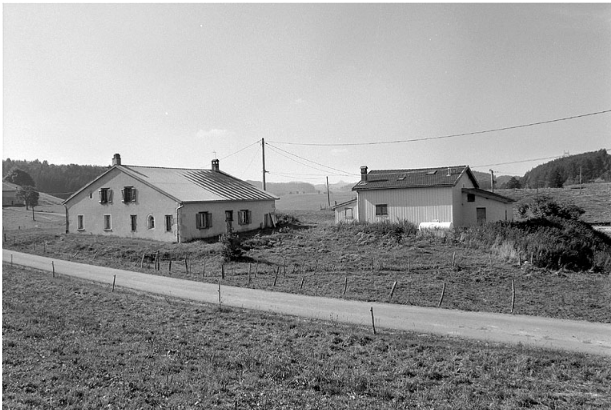
Vue générale de la fromagerie et de la porcherie.
