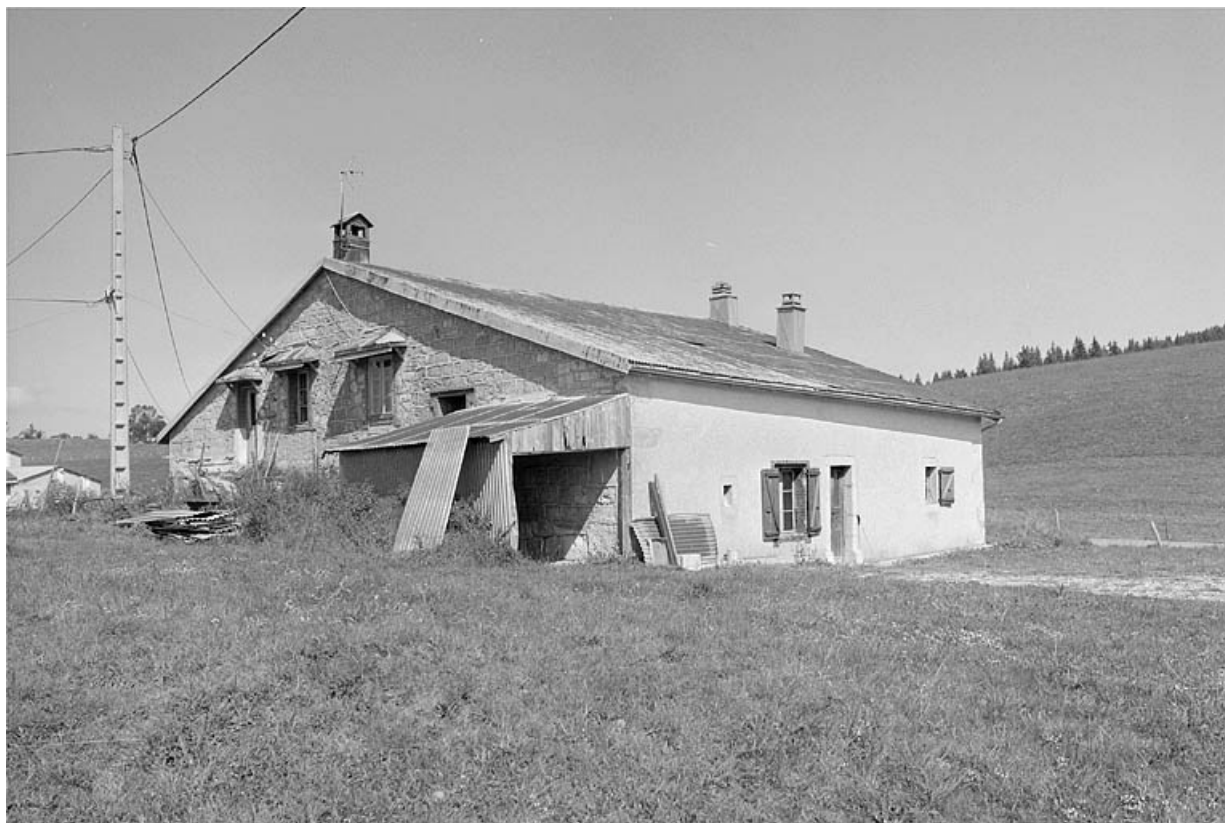
Façade postérieure et face droite.
