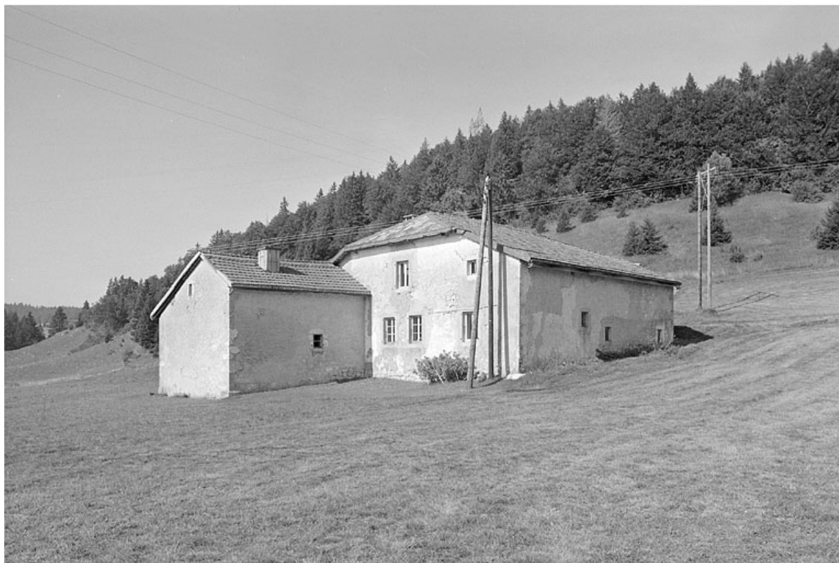
Face sud-est et façade postérieure.
