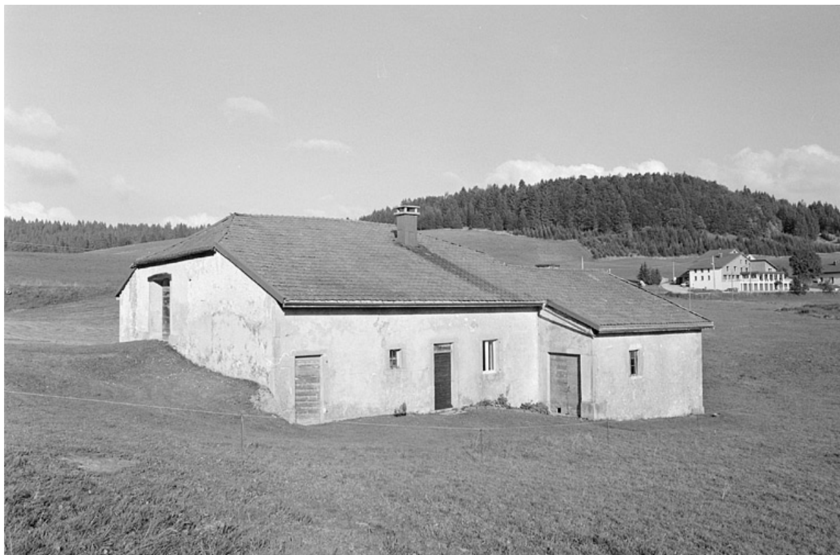
Façade antérieure et face nord-ouest.
