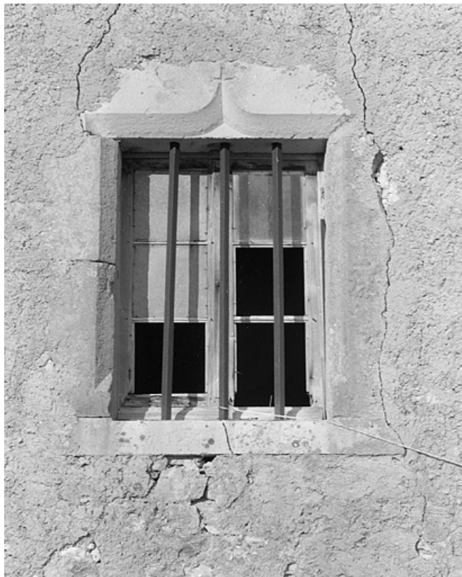
Une fenêtre au linteau en accolade.
