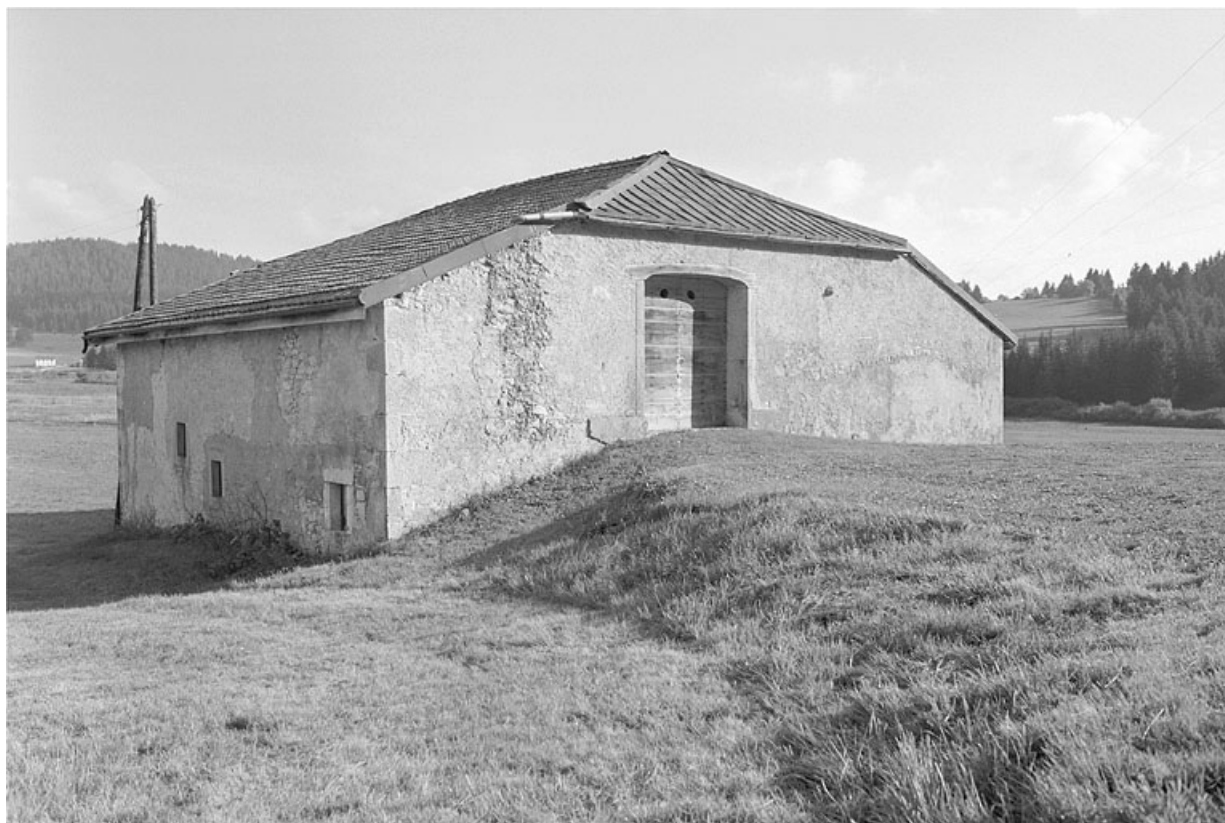
Façade postérieure et accès à la grange haute.
