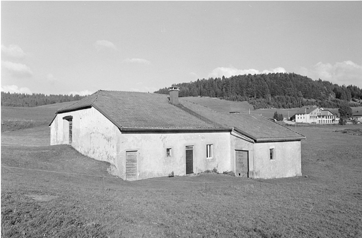
Façade antérieure et face nord-ouest.
