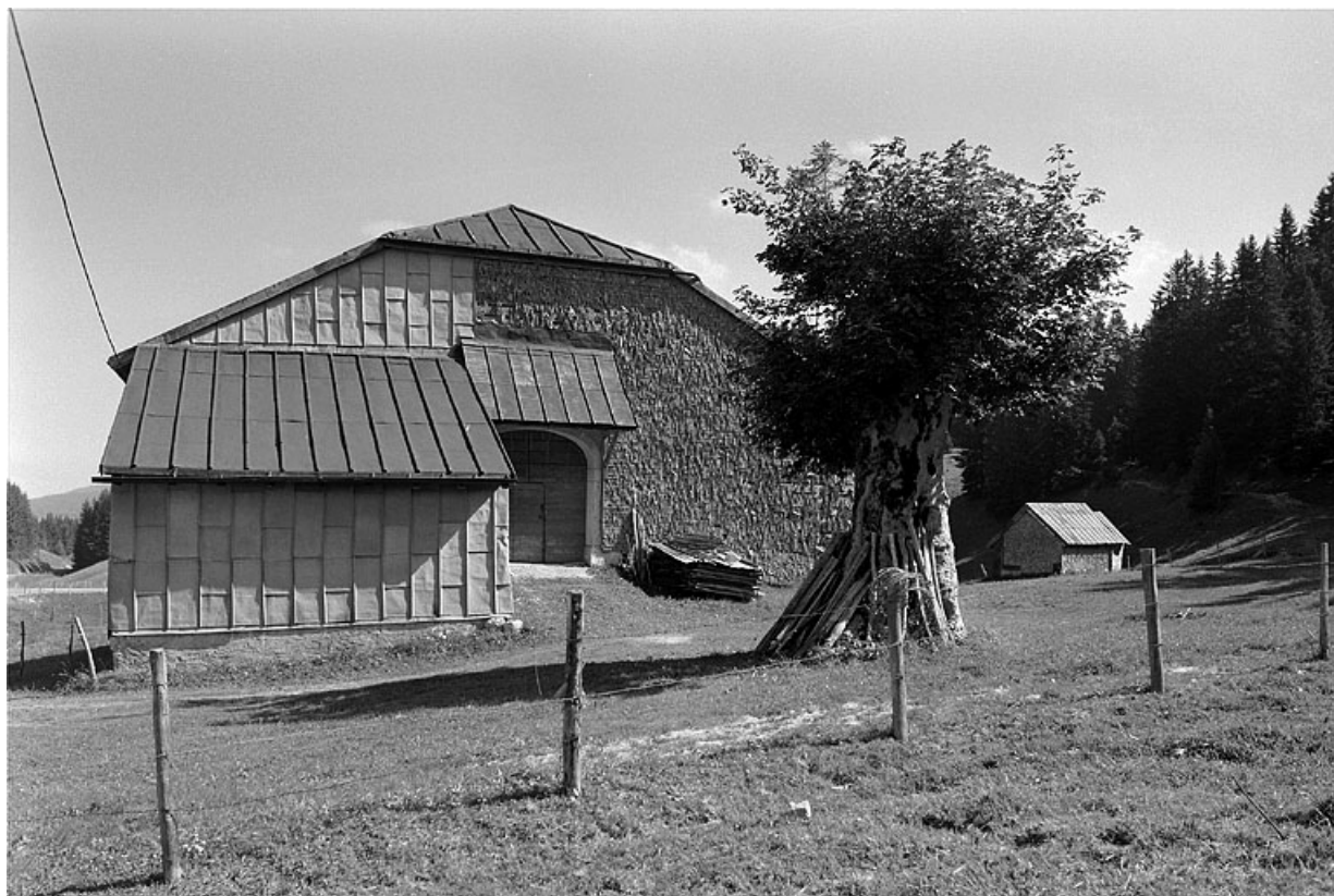
Face sud-ouest d'une ferme et son grenier fort.
