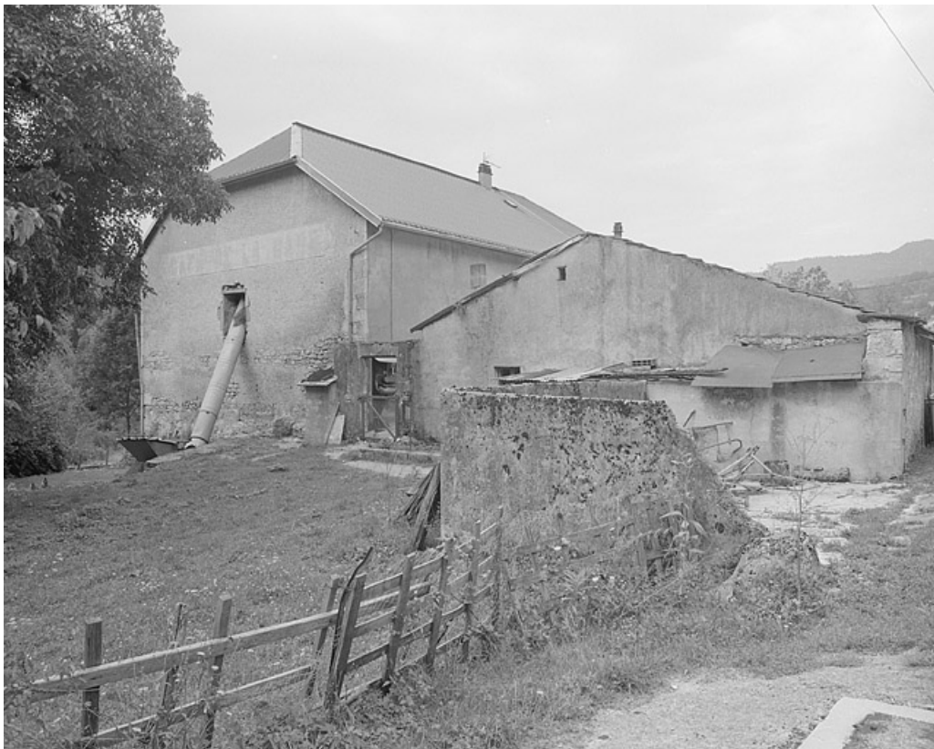
Face est de la ferme portant l'inscription « café de la gare ». 39, Lavans-lès-Saint-Claude, 50, 52 quartier de Lizon, lieudit : Lizon
