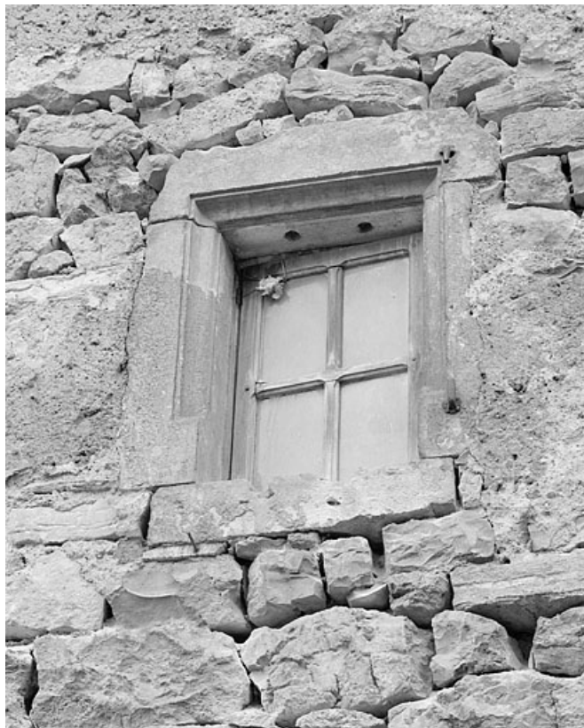
Détail d'une fenêtre sur la façade postérieure.
