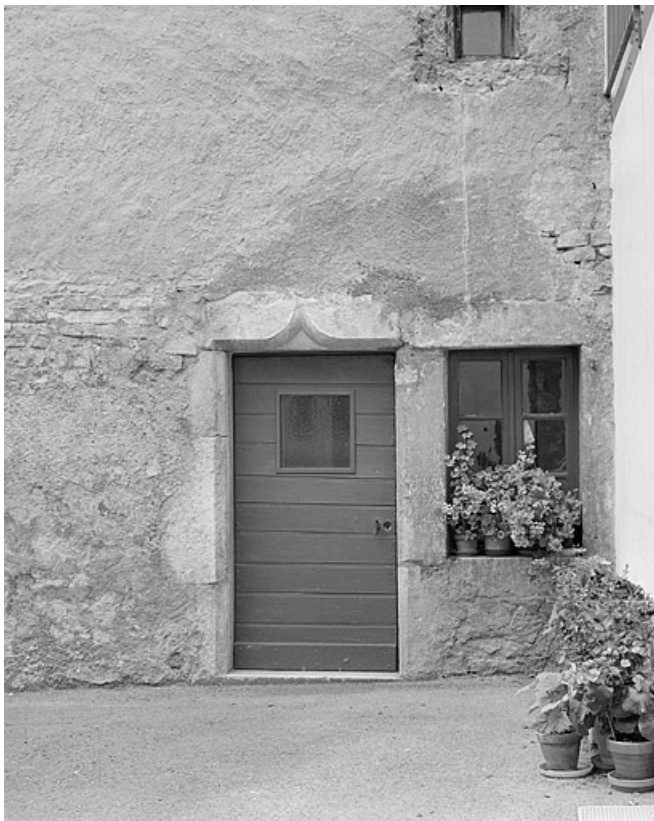
Porte d'accès avec linteau en accolade.
