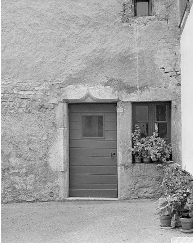
Porte d'accès avec linteau en accolade.
