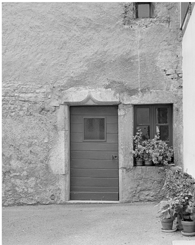
Porte d'accès avec linteau en accolade.
