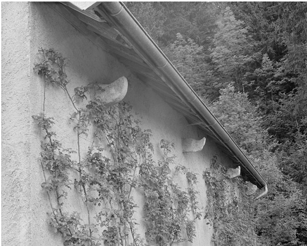
Corbeaux soutenant le chéneau amenant l'eau du toit à la citerne.
