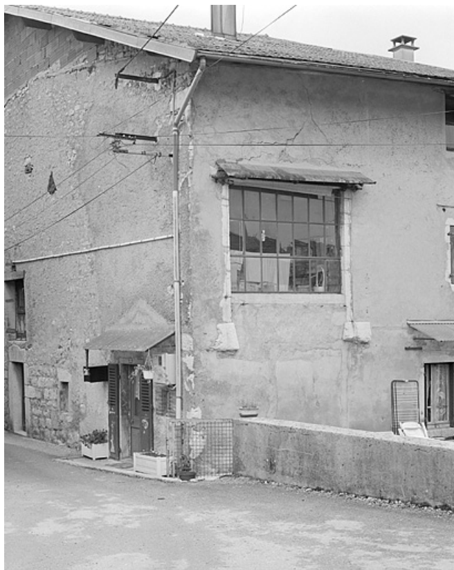
Atelier installé dans la grange haute d'une ferme. 39, Lavans-lès-Saint-Claude
