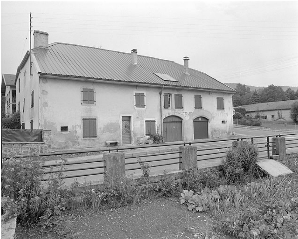
Le bâtiment abritant à l'origine le magasin de la Fraternelle. 39, Lavans-lès-Saint-Claude
