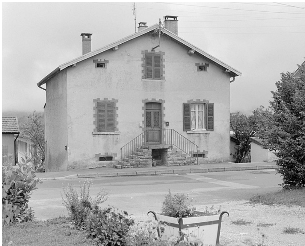
Maison, rue de la Cueille. 39, Lavans-lès-Saint-Claude
