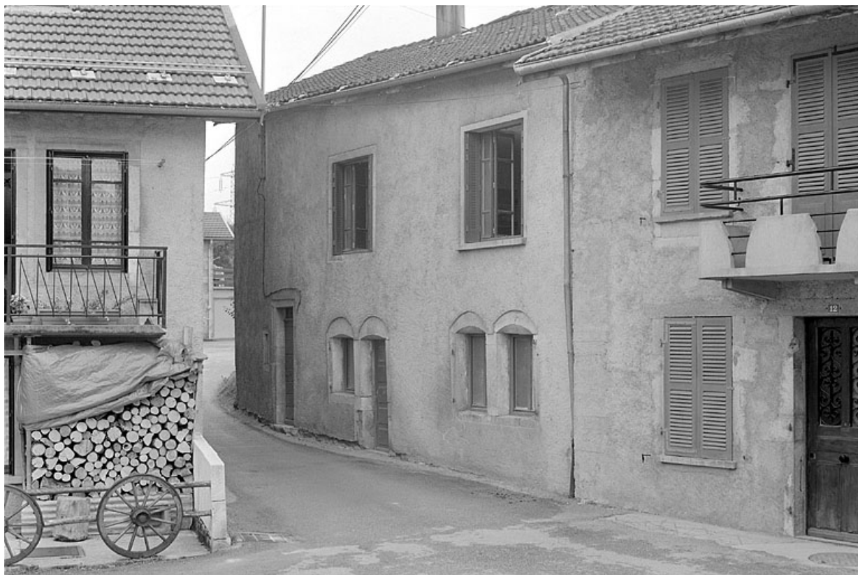
Quartier du Bourg Dessus. 39, Lavans-lès-Saint-Claude
