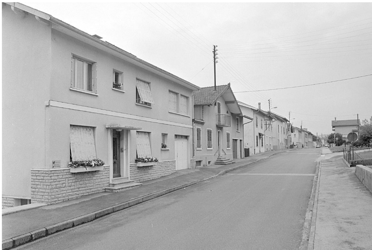
Rue de la Cueilie, lotissement du début du 20e siècle.
