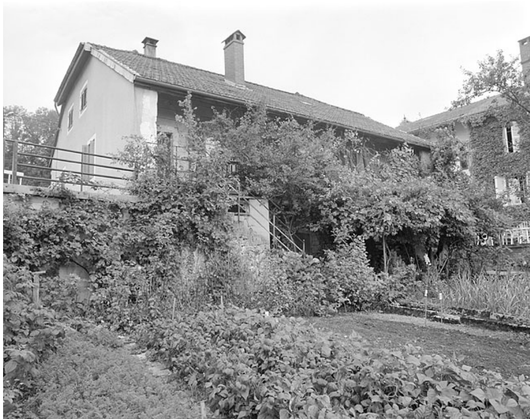
Façade postérieure de l'ancienne maison communale.
