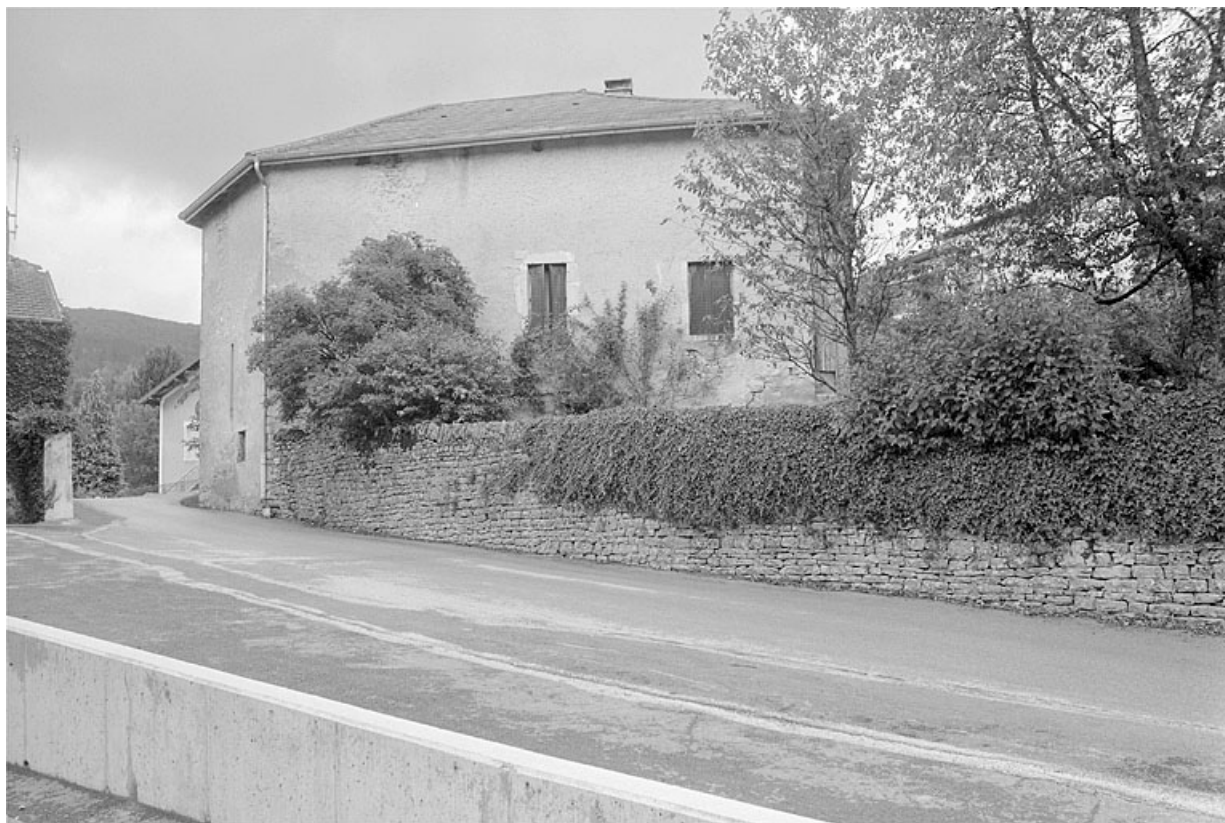
Face sud depuis la rue du curé Marquis.
