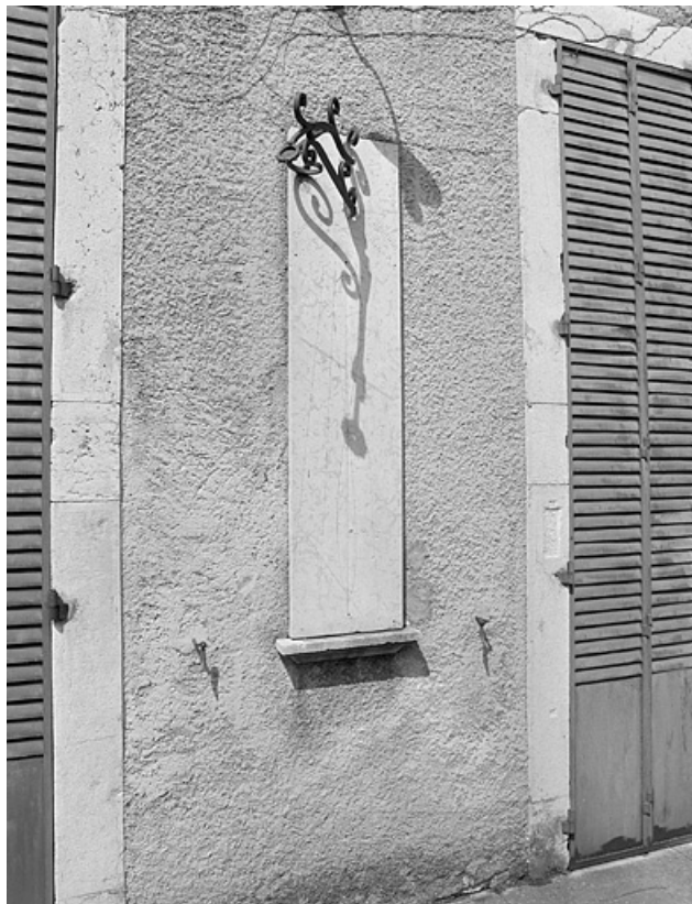
Détail du cadran solaire de la demeure. 39, Saint-Lupicin, 6, 8 rue du Curé Marquis
