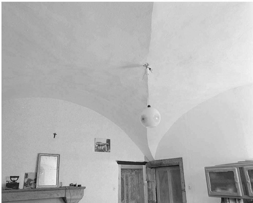
Pièce du rez-de-chaussée, voûte d'arêtes.
