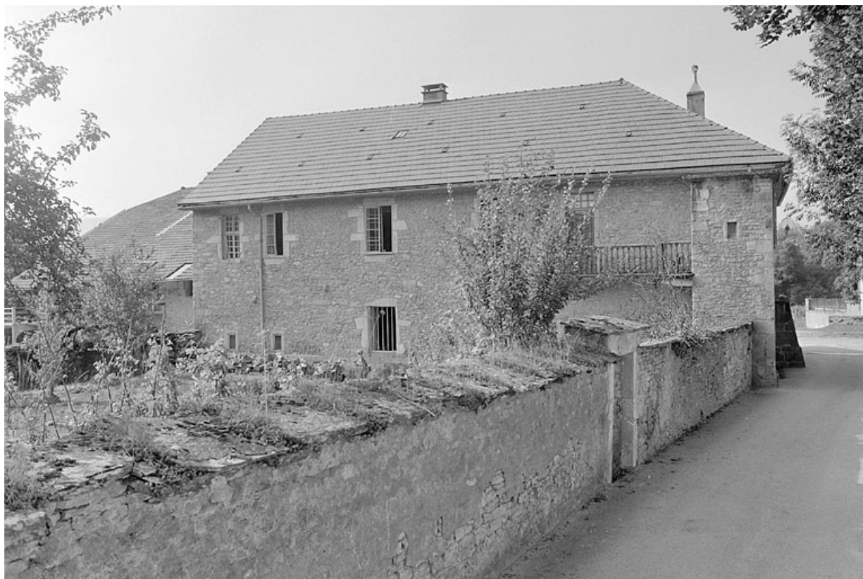
Façade postérieure depuis la rue du curé Marquis.
