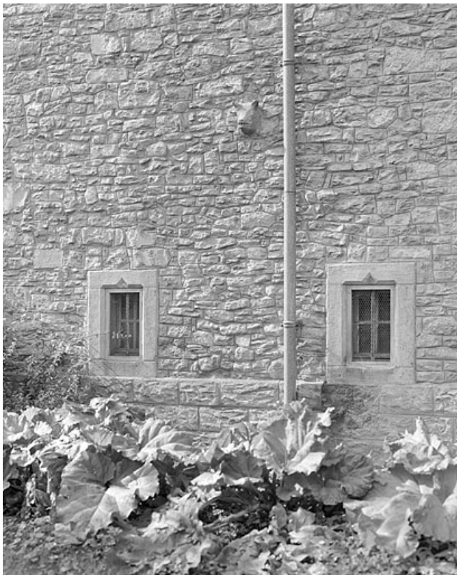
Façade postérieure, détail de deux fenêtres et d'une sculpture portée sur le mur. 39, Saint-Lupicin, 7 rue du Curé Marquis
