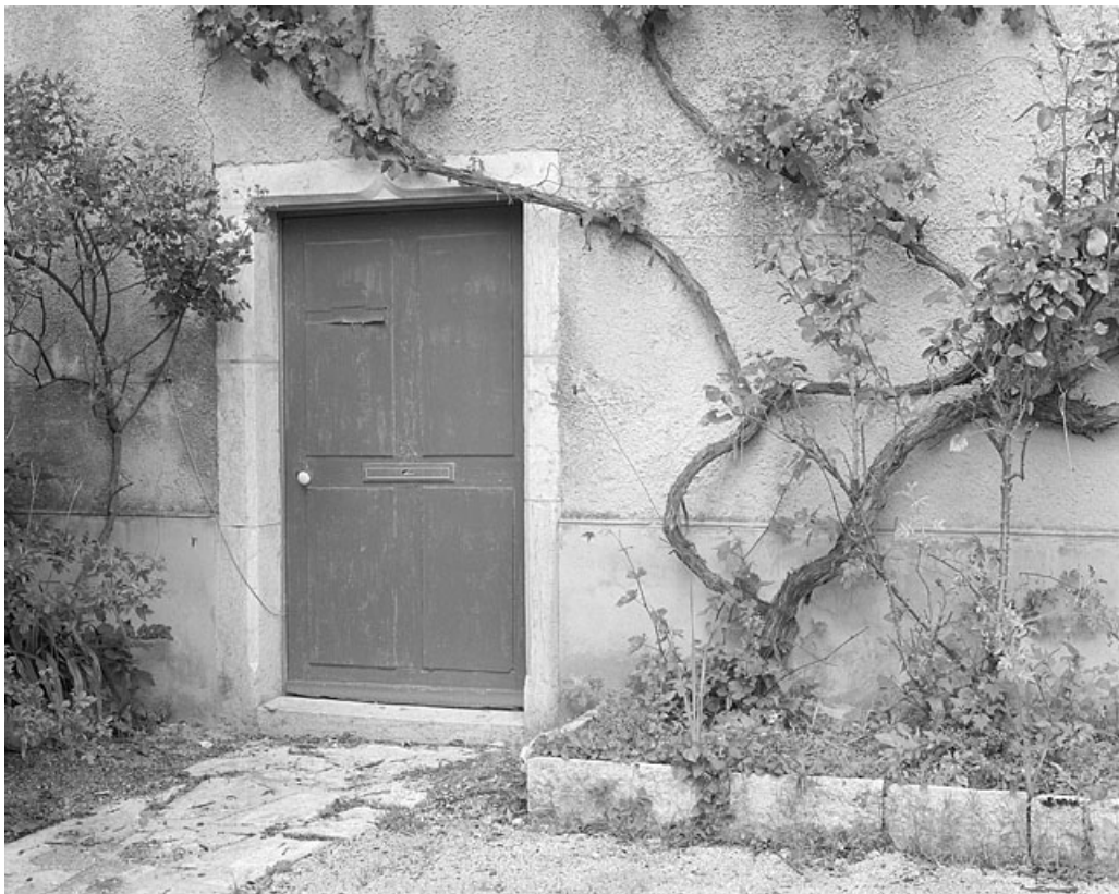
Façade antérieure, détail d'une porte. 39, Saint-Lupicin, 7 rue du Curé Marquis
