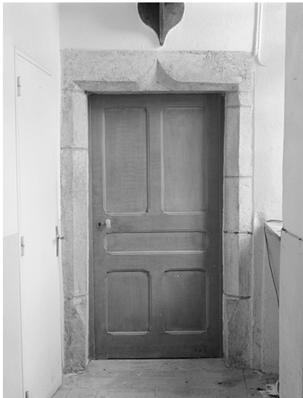
Porte intérieure avec linteau en accolade.
