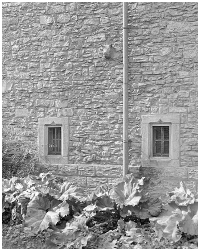
Façade postérieure, détail de deux fenêtres et d'une sculpture portée sur le mur.
