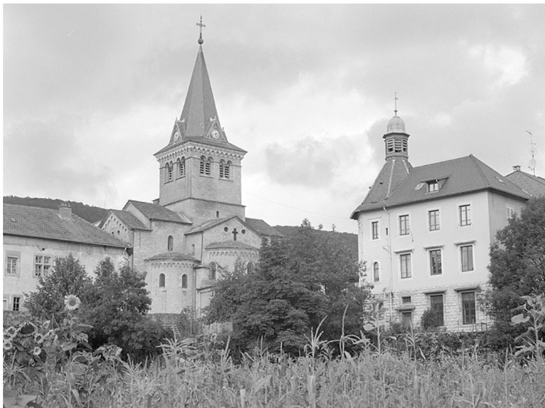
L'église paroissiale et l'ancienne mairie.
