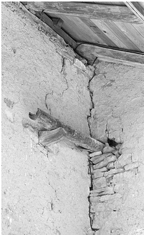
Chéneau amenant l'eau du toit à la citerne.
