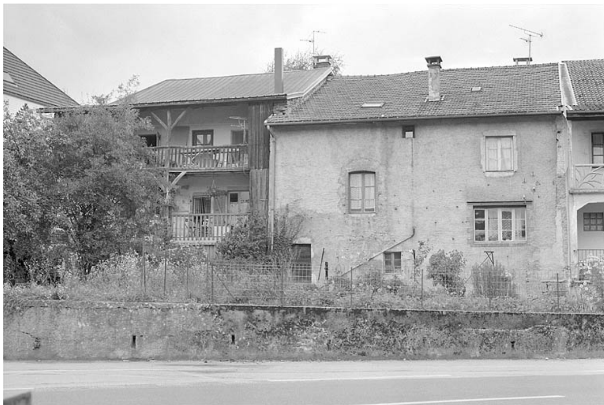
Grande Rue, façades postérieures d'anciennes fermes.
