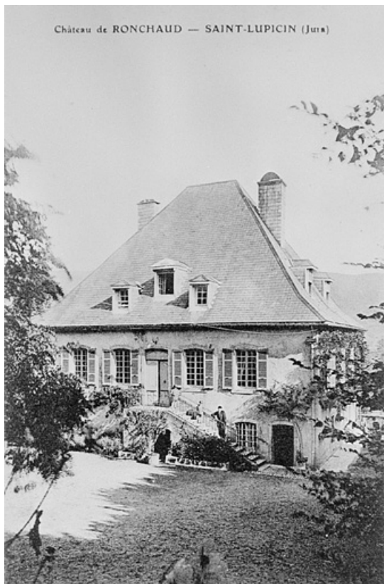
Façade principale du château de Ronchaud. 39, Saint-Lupicin
