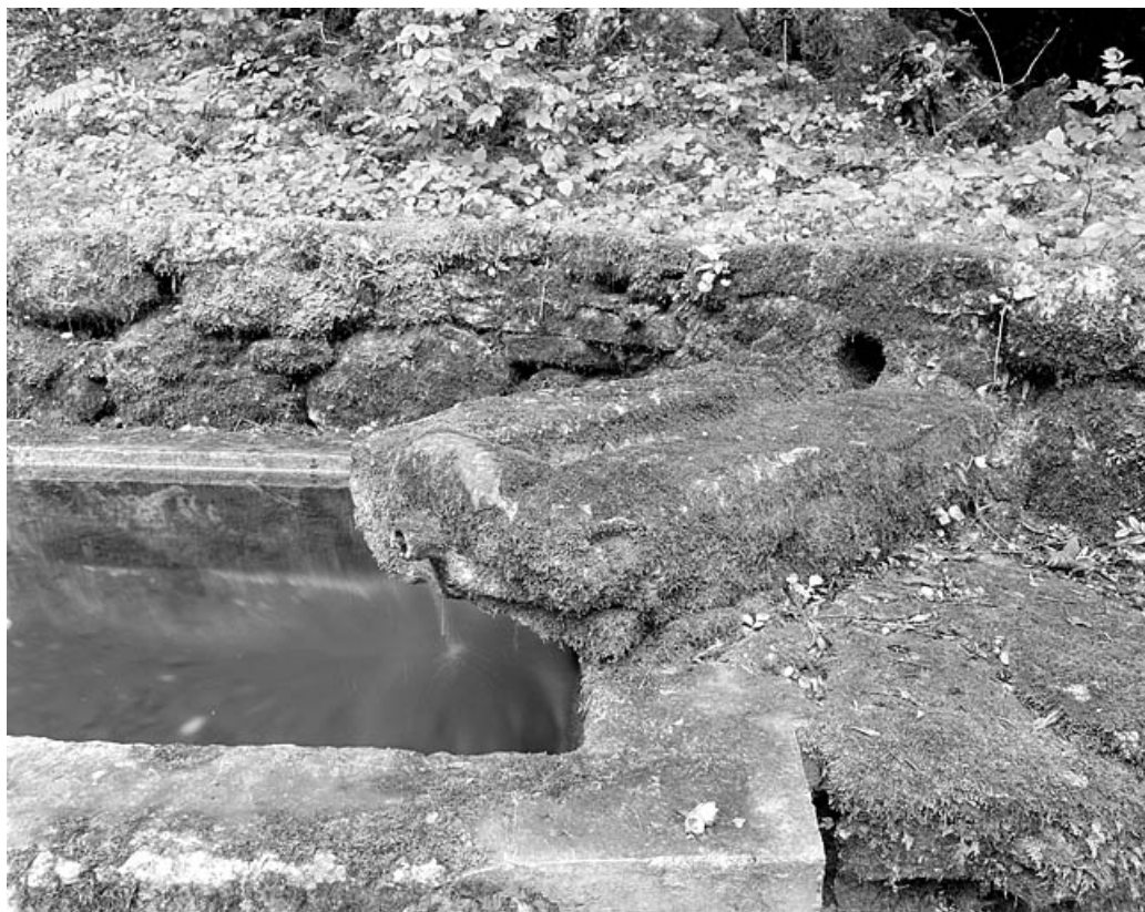
Détail d'une goulotte en pierre amenant l'eau dans le bassin.
