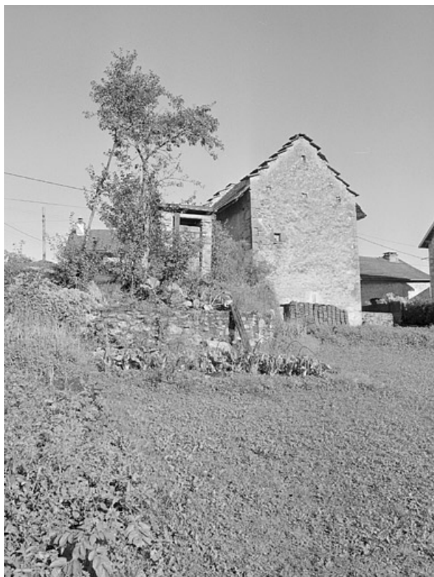
L'ancienne fromagerie de Ponthoux, façade postérieure. 39, Ponthoux
