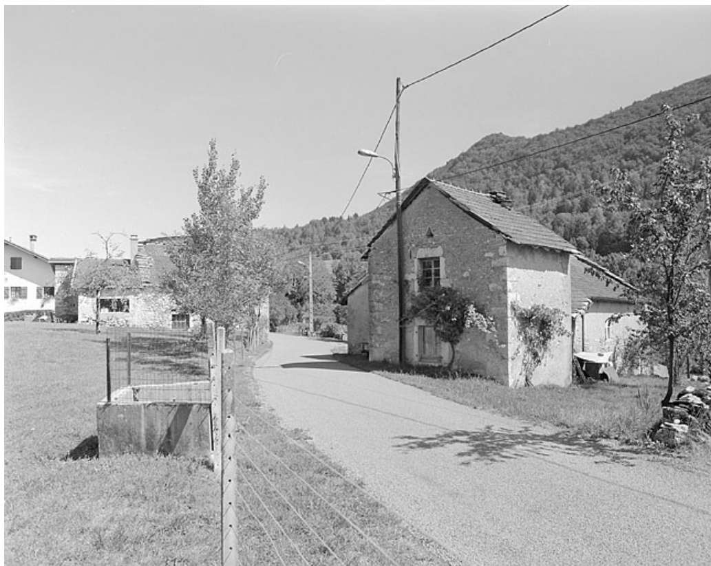
Rue principale du village.
