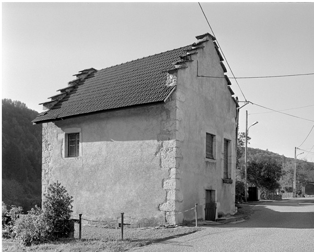
Façade antérieure et face droite.
