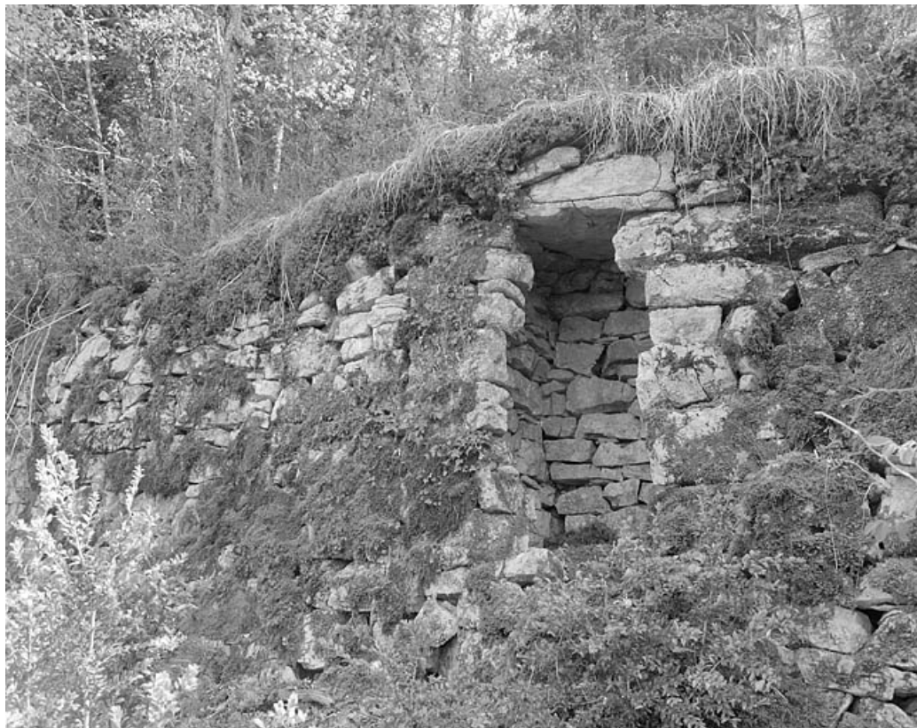
Cabane dans un mur de soutènement, au lieu-dit Sous les Vignes. 39, Ponthoux
