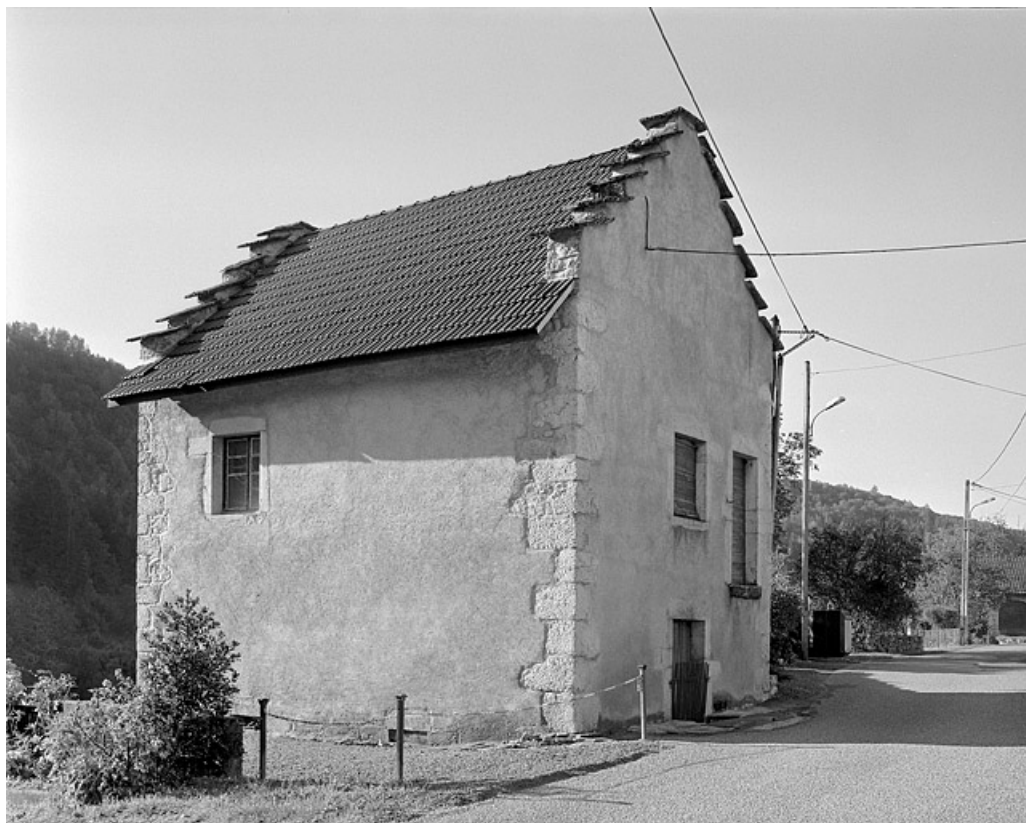
Façade antérieure et face droite.
