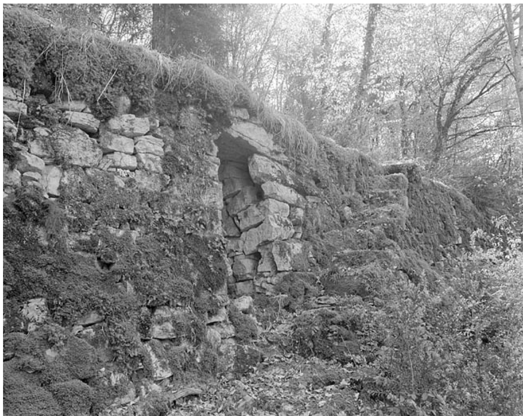
Anciens murs soutenant des terrasses cultivées, au lieu-dit Sous les Vignes. 39, Ponthoux
