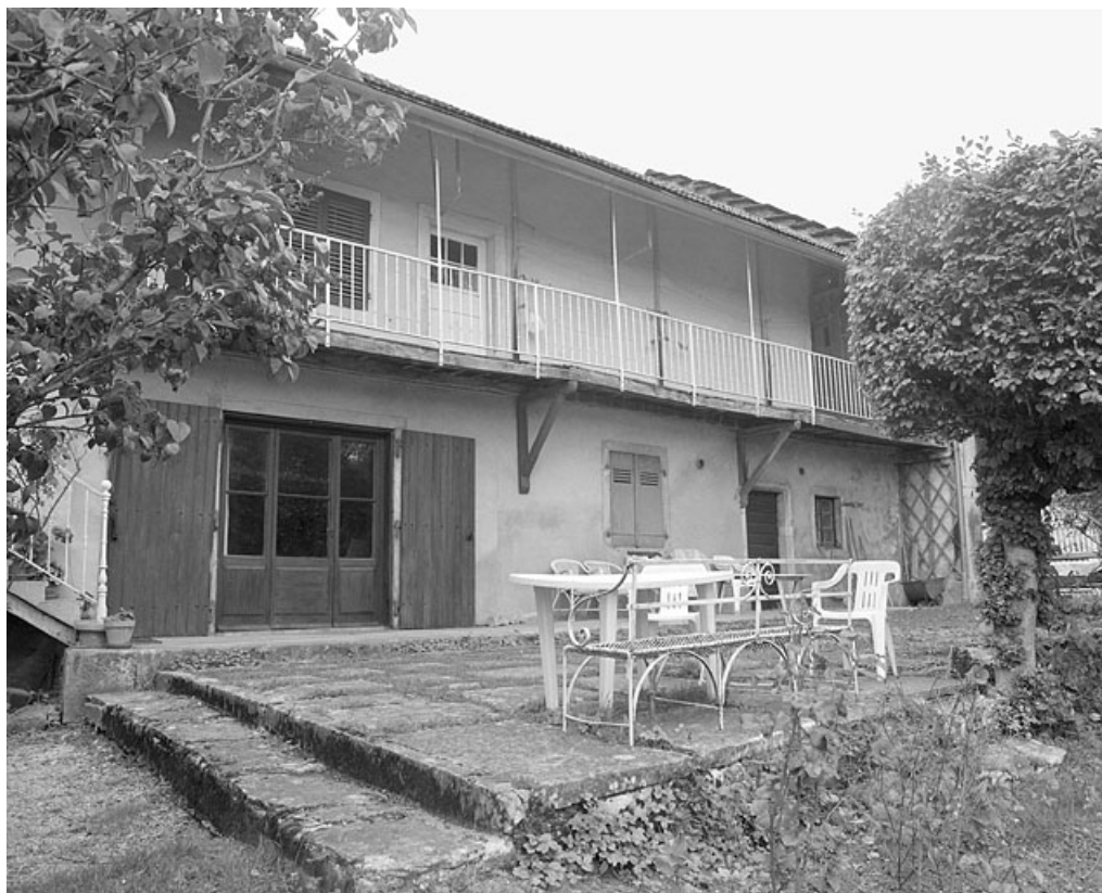
Façade postérieure de la ferme.
