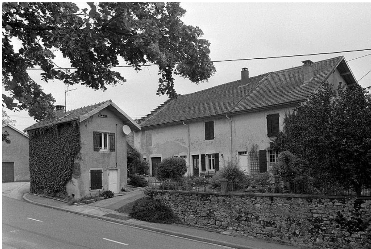
Vue des façades antérieures de la ferme et de la buanderie.
