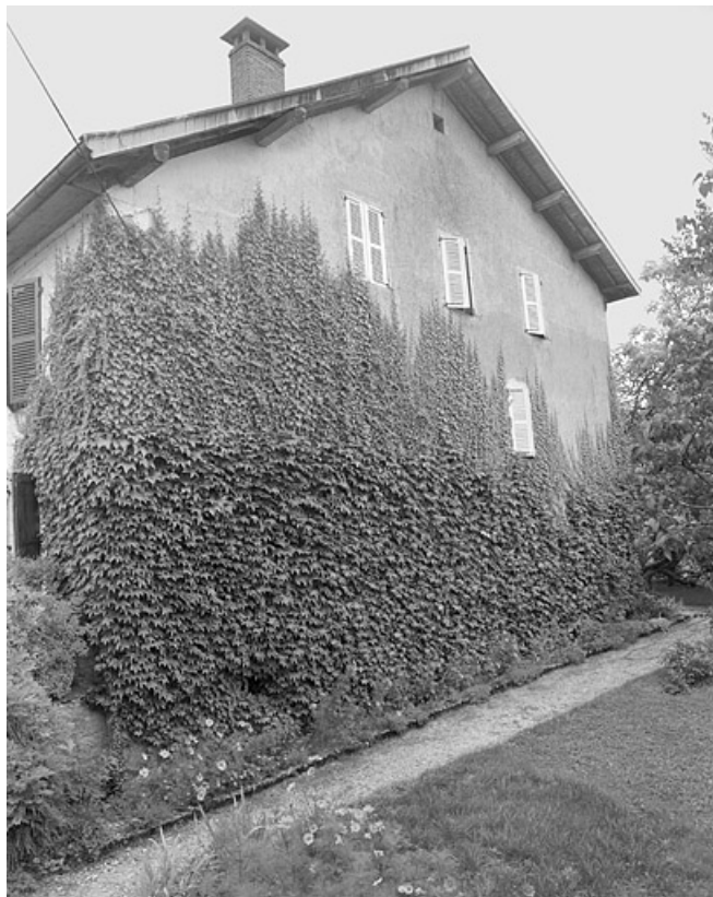
Face sud de la ferme.
