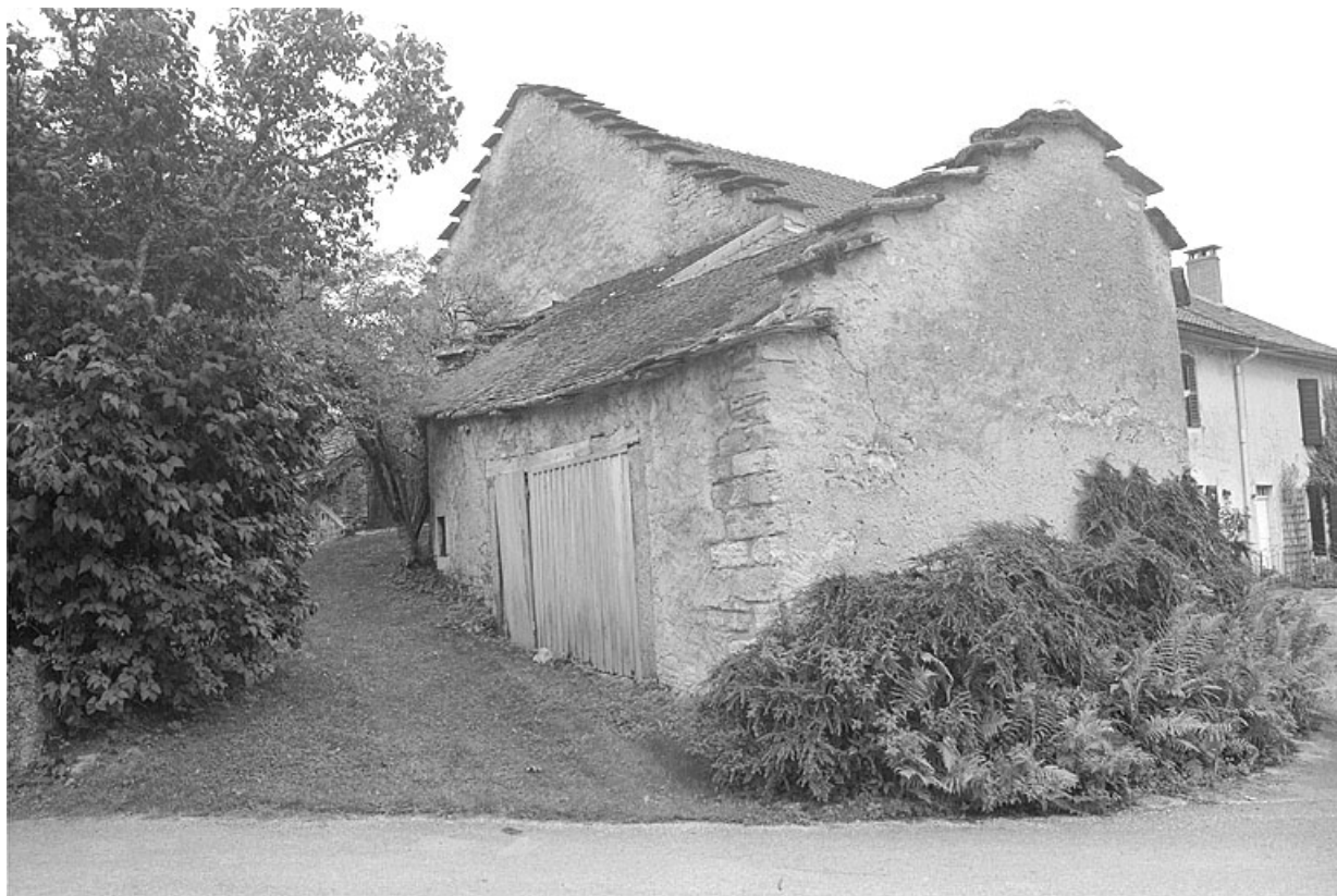
Pignons à redents de la ferme et de la remise.
