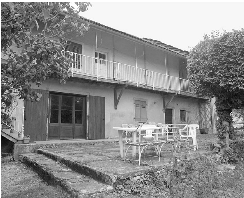
Façade postérieure de la ferme.
