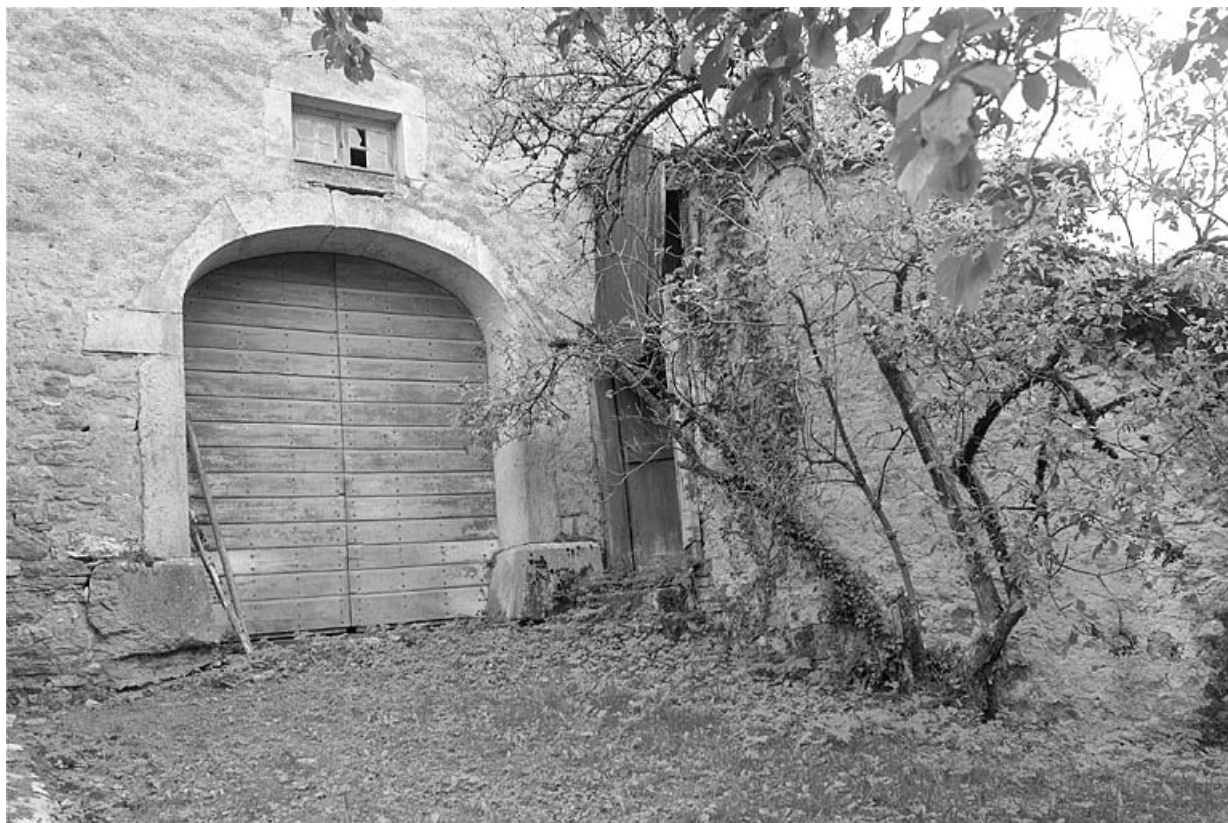
Grange haute sur la face nord de la ferme.
