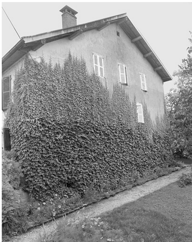
Face sud de la ferme.
