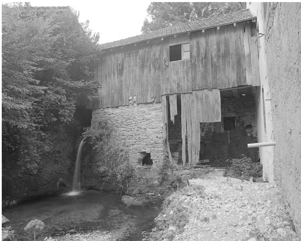
Façade postérieure de la scierie, sur le ruisseau des Thureys.
