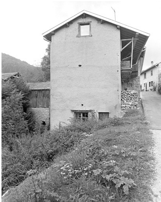
Face gauche de l'atelier de tournerie.
