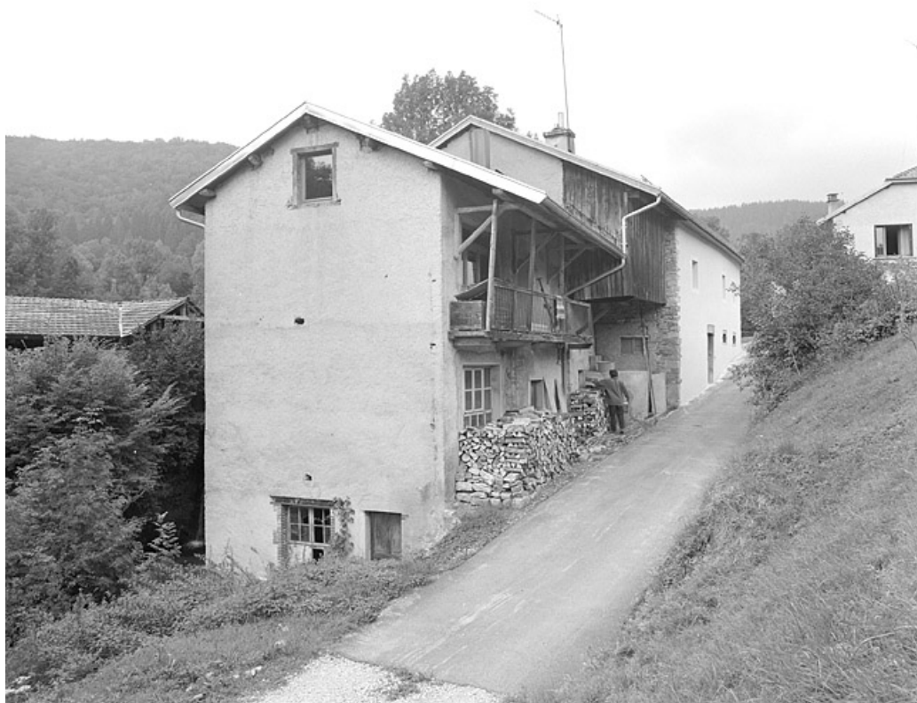
L'atelier de tournerie, façade avec balcon et le four accolé à la ferme.
