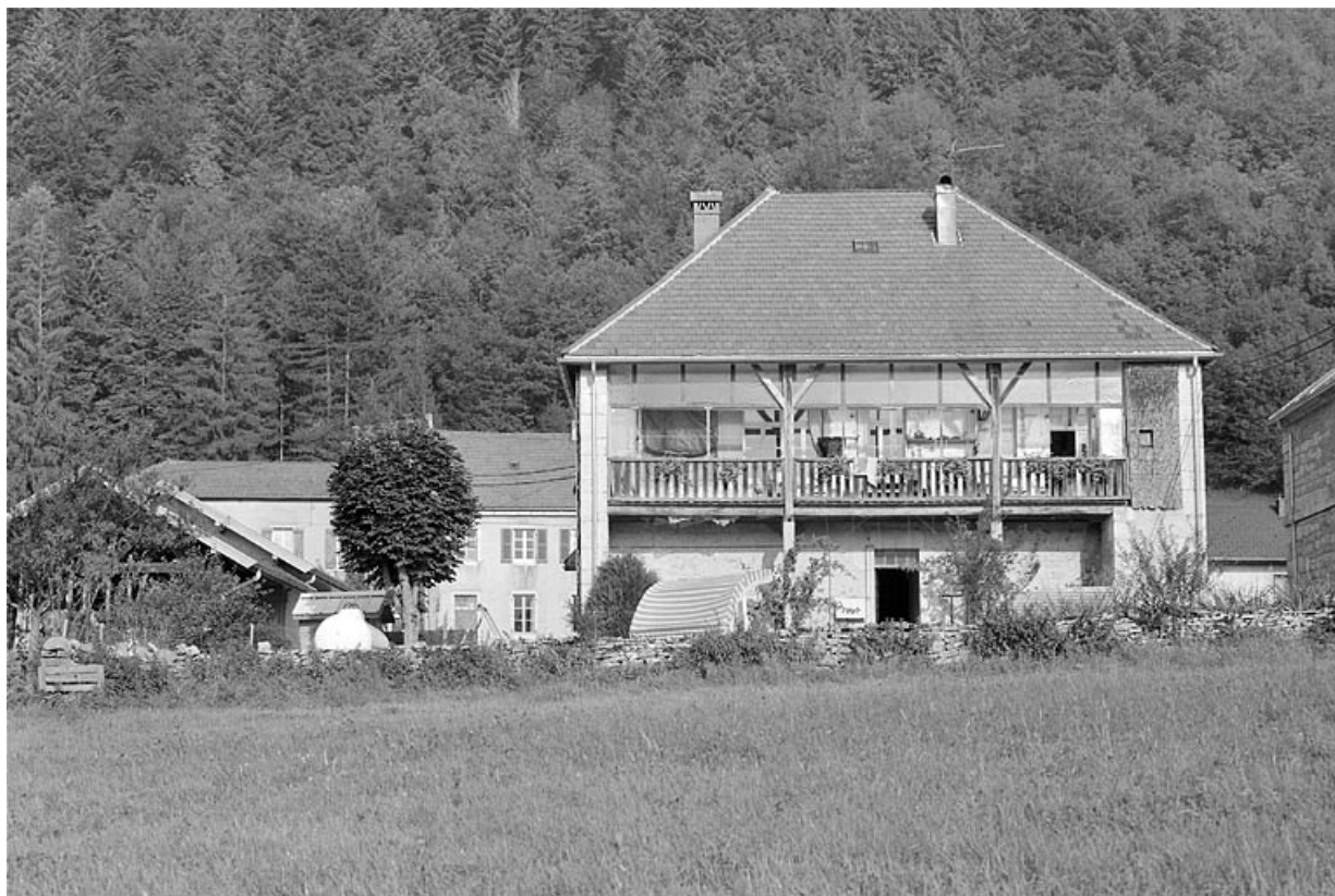
Vue générale de la façade postérieure.
