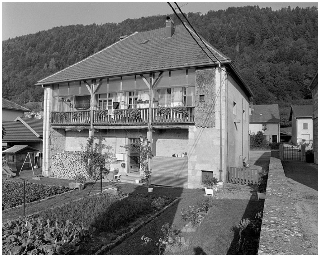
Façade postérieure. 39, Leschères Eglise
