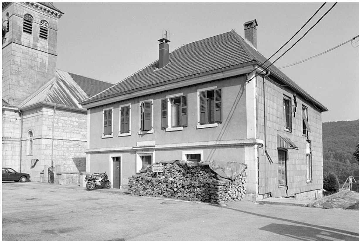
Vue générale depuis la place de l'Eglise.
