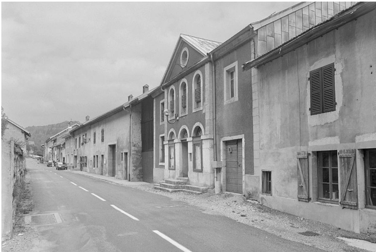
Vue depuis la rue principale.
