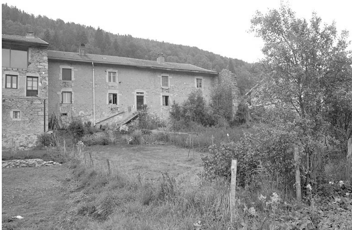
Façade postérieure, vue générale.
