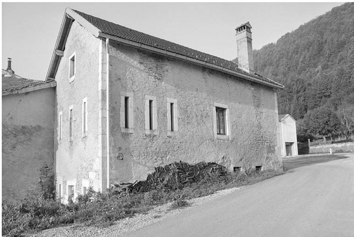
Face gauche et façade postérieure.
