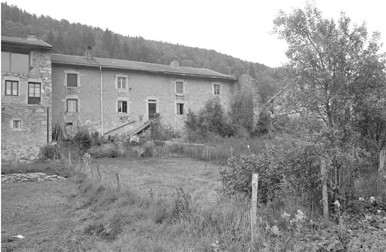
Façade postérieure, vue générale.
