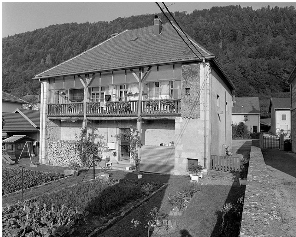
Façade postérieure. 39, Leschères Eglise
