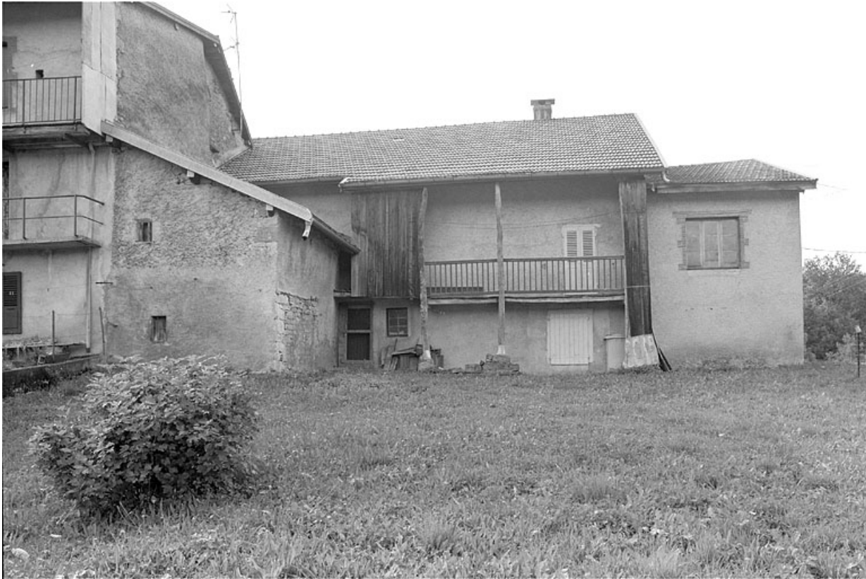
Façade postérieure, avec la porcherie en appentis et à droite l'atelier. 39, Cuttura C.D. 233 E3
