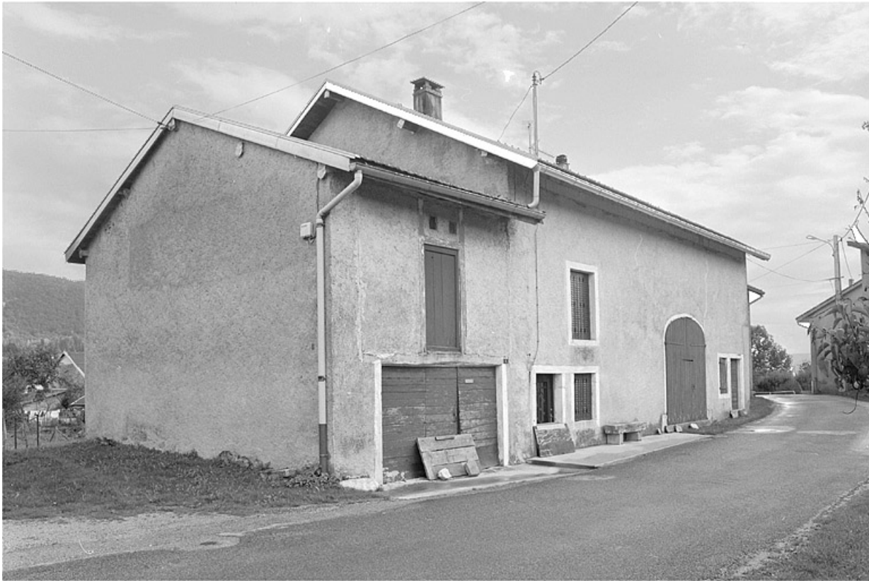
Façade sur rue avec, au premier plan, l'atelier.
