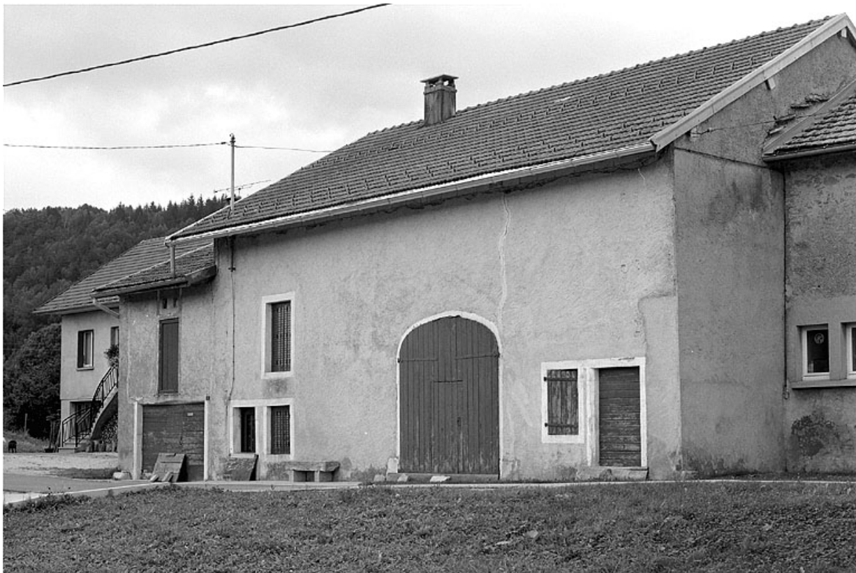
Façade sur rue avec les entrées du logis, de la grange et de l'étable. 39, Cuttura C.D. 233 E3
