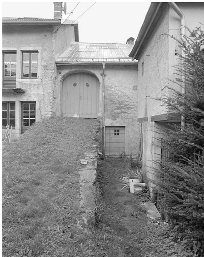
Face nord, entrée de la grange haute et étable en contrebas. 39, Cuttura C.D. 233
