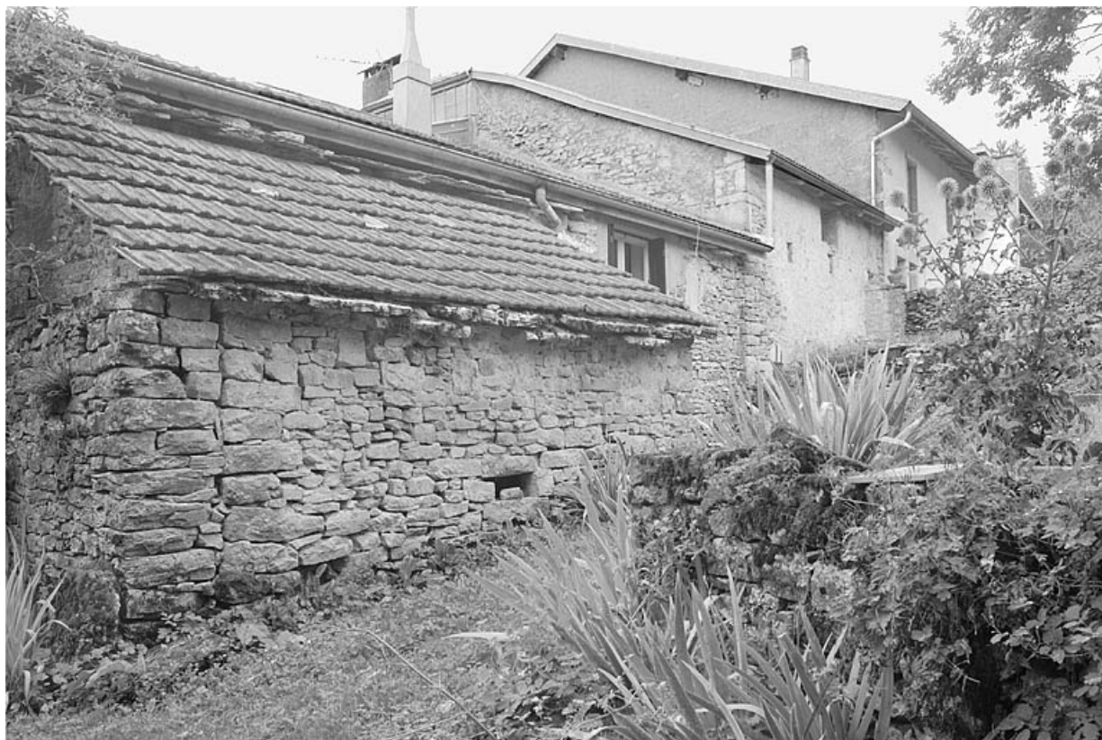
Face sud-est, appentis avec une ancienne couverture en calcaire. 39, Cuttura C.D. 233
