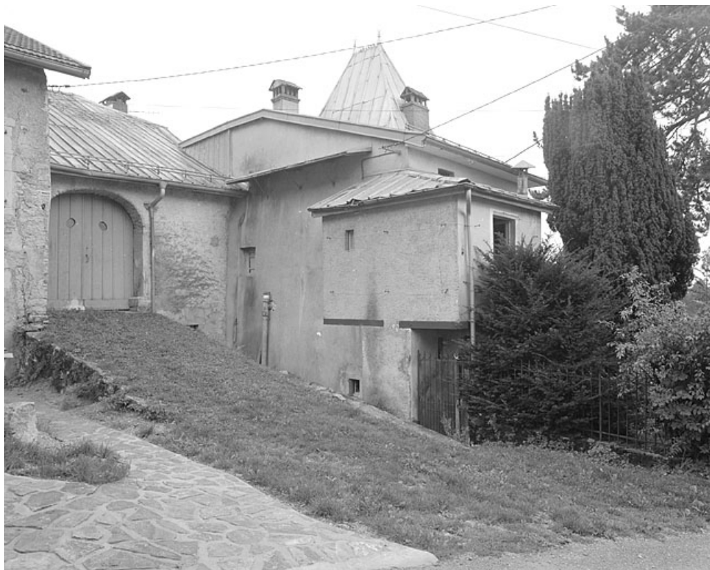
Façade postérieure de la demeure.
