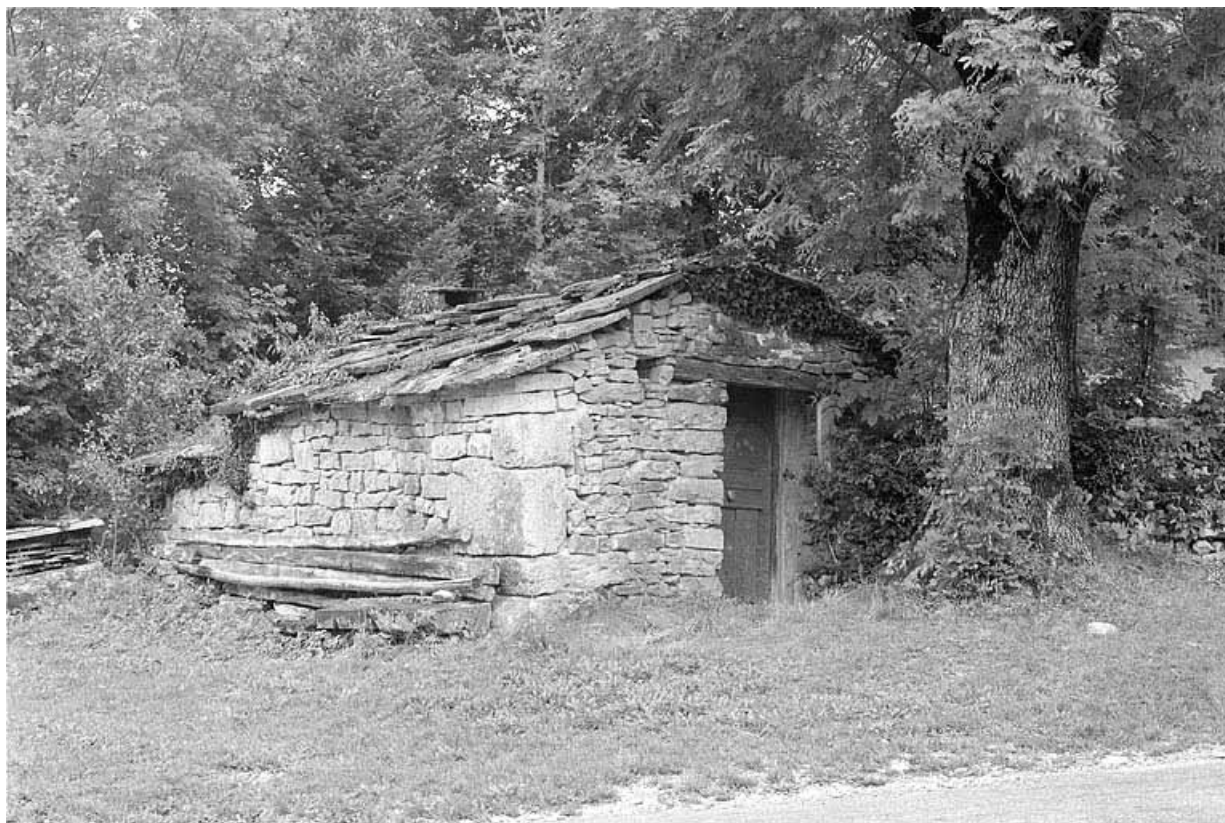
Fornil couvert en pierres calcaires.
