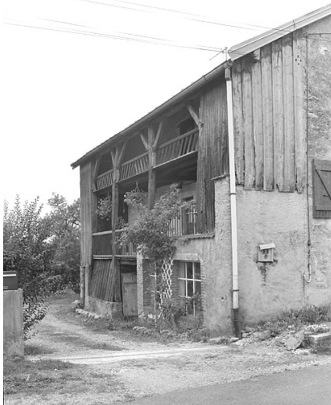
Ferme avec balcon en galerie sur deux niveaux. 39, Cuttura
