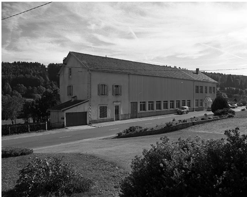
Façade antérieure vue de trois quarts gauche.
