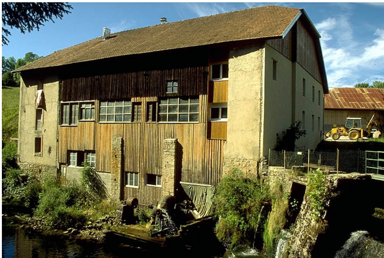
Façade postérieure du moulin Choudet.
