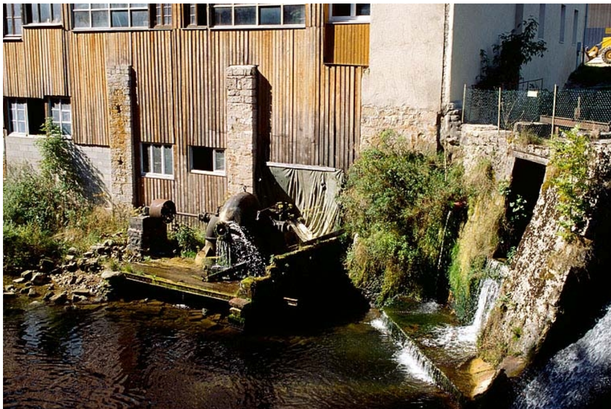
Moulin Choudet : la turbine et le barrage. 39, Fonceine-le-Haut Grande Rue 1, 2, 4, 6, 8
