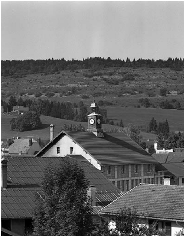
La toiture de l'usine depuis le sud-est.
