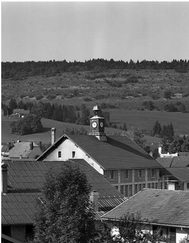
La toiture de l'usine depuis le sud-est.
