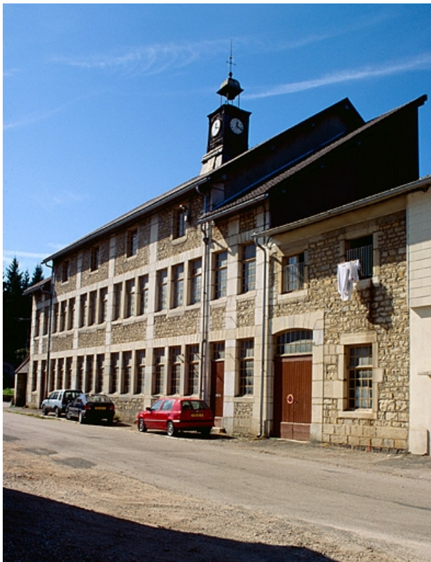
Façade de l'atelier de fabrication de trois quarts droit.
