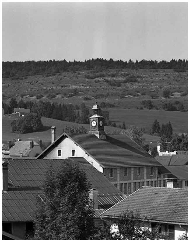
La toiture de l'usine depuis le sud-est.
