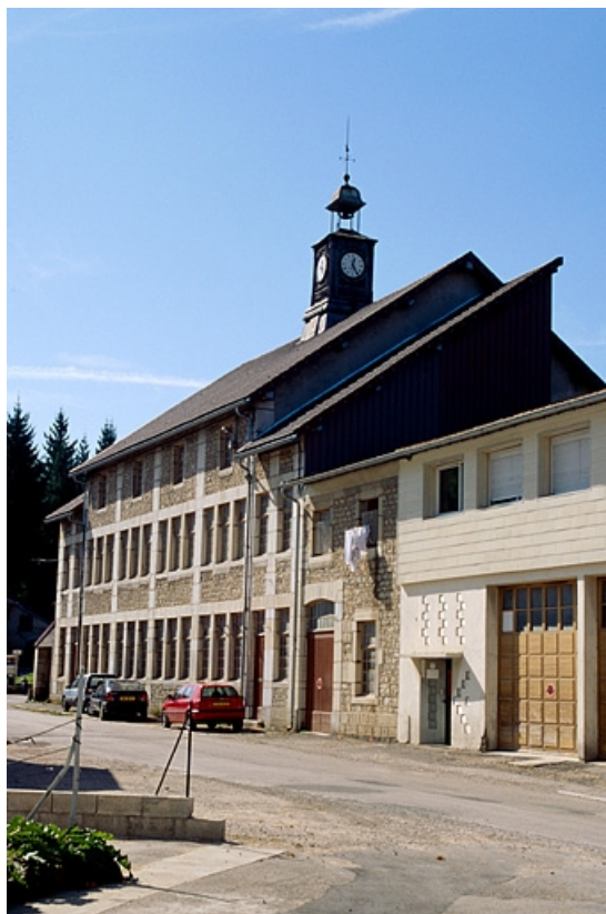
Façade antérieure de l'atelier de fabrication.
