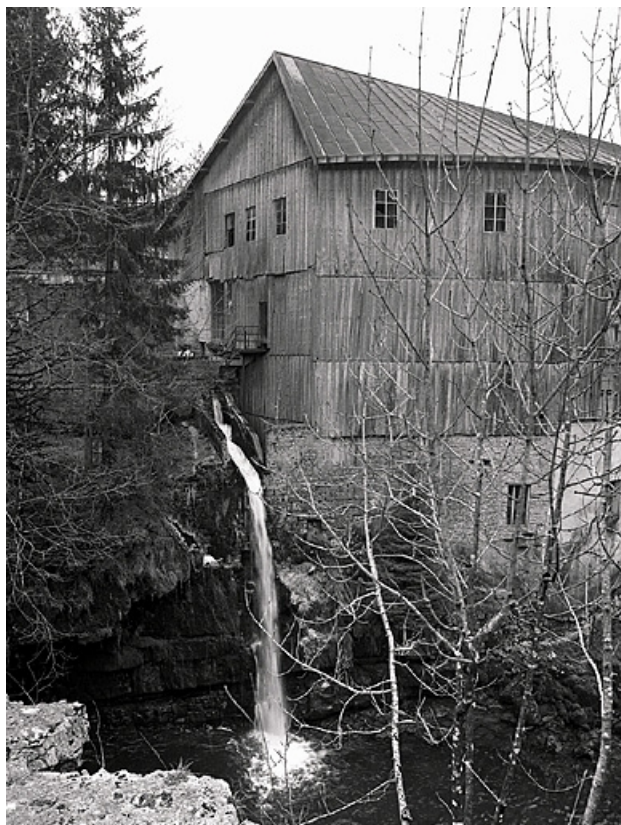
Extrémité est de l'atelier de fabrication.
