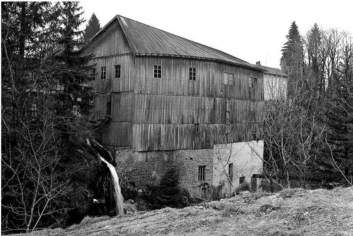
Façade sur rivière de l'atelier de fabrication de scierie.
