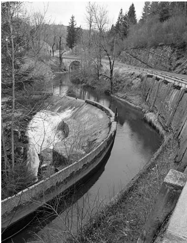
Canal d'amenée de la centrale.
