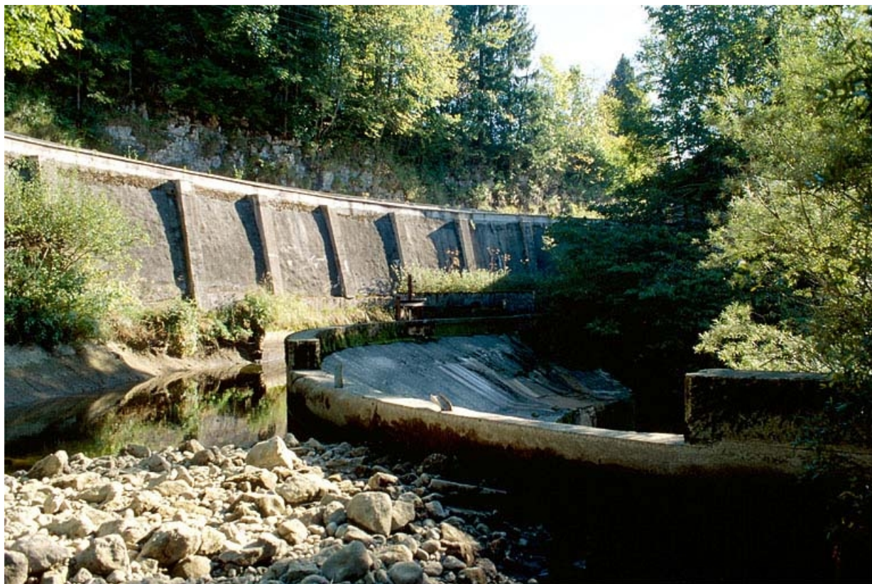
Canal d'amenée et déversoir du barrage.
