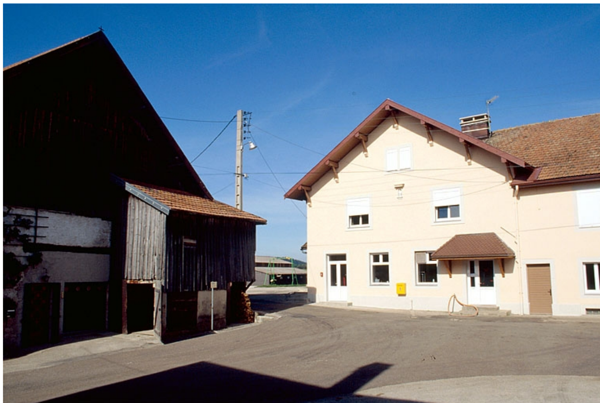
Pignon sud-est de la fromagerie.
