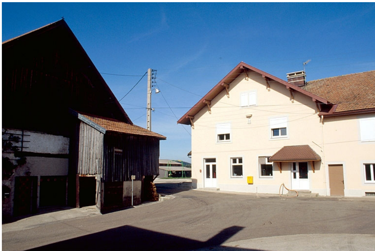
Pignon sud-est de la fromagerie.
