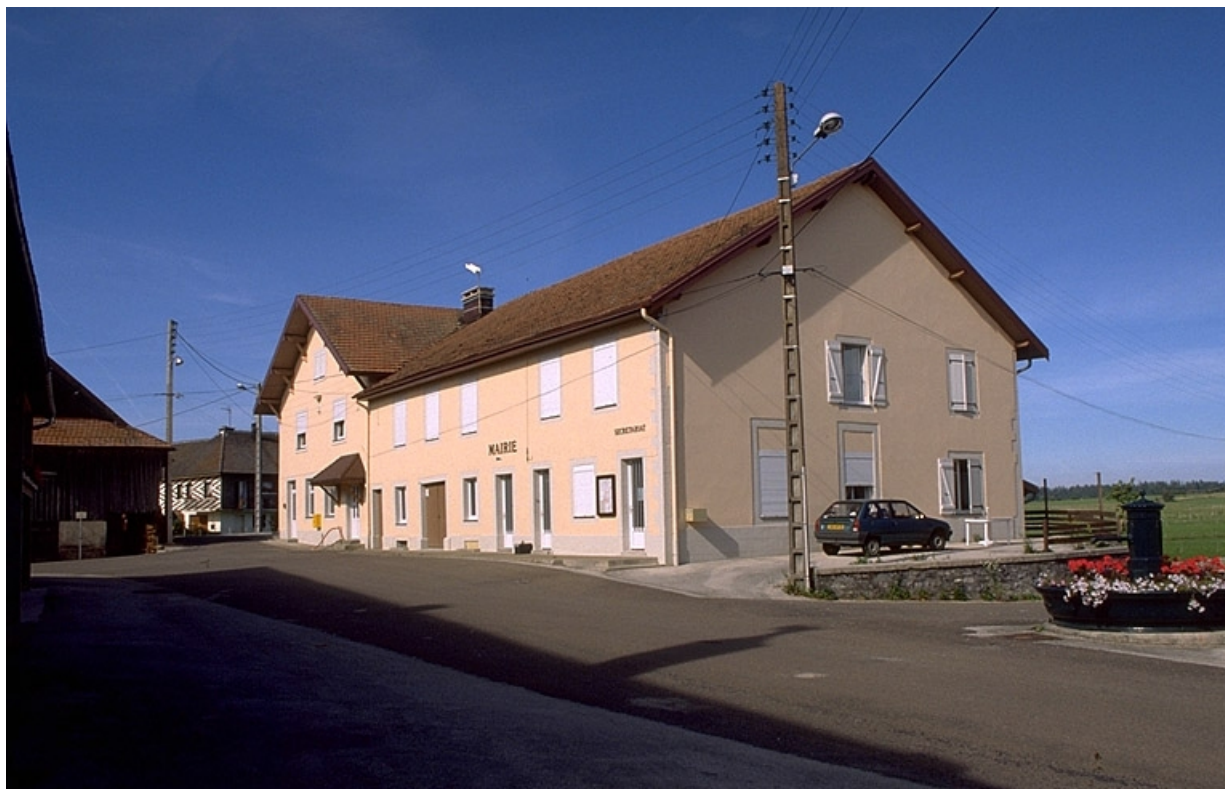
Façade antérieure vue de trois quarts droite.
