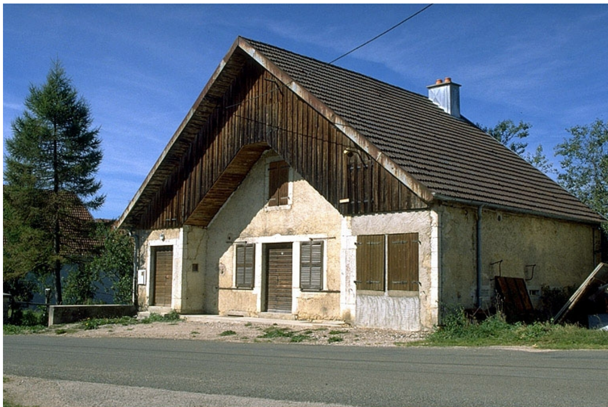
Vue de trois quarts droit. 39, Bief-du-Fourg R.D. 64
