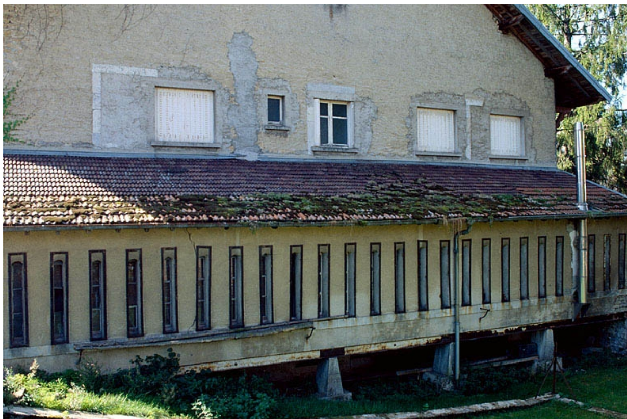
Ancienne chambre à lait en façade postérieure.
