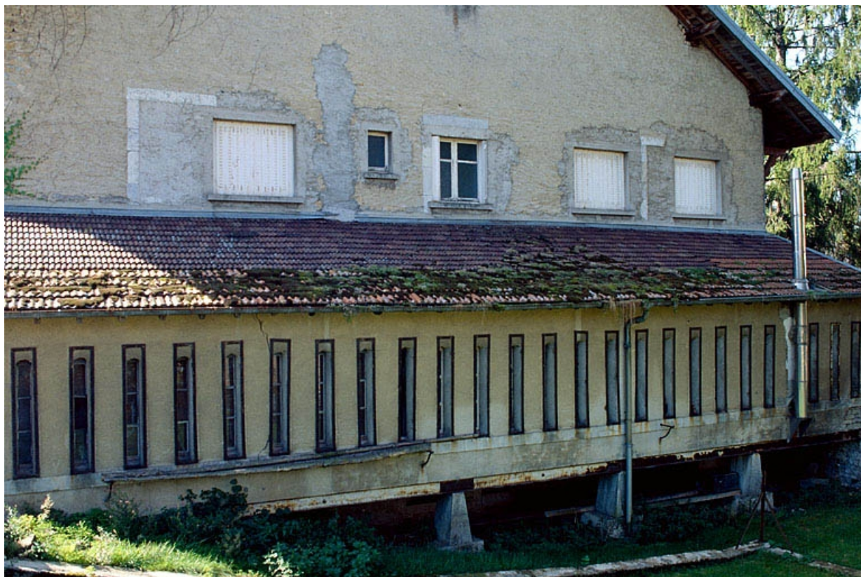
Ancienne chambre à lait en façade postérieure.
