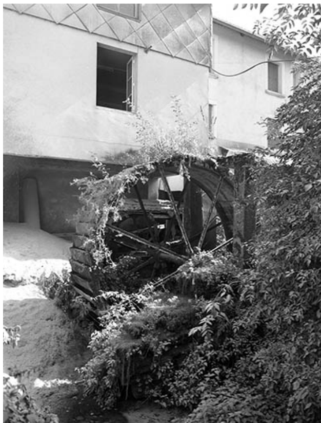
Roue hydraulique sur la façade postérieure.
