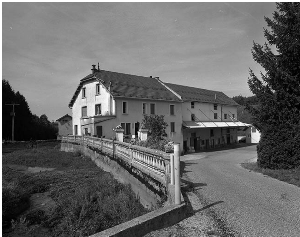
Bassin de retenue (hors eau), logement et atelier de fabrication.
