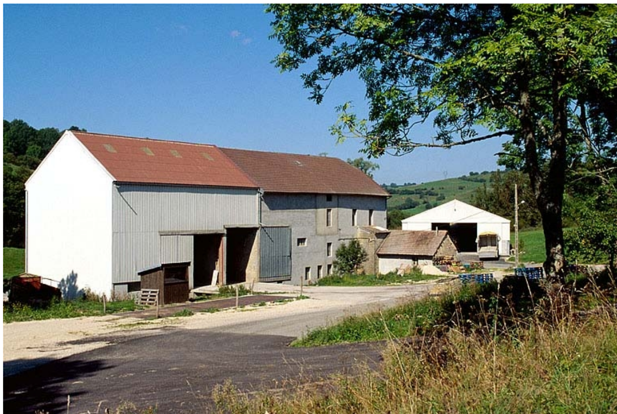
Façade postérieure de trois quarts arrière.
