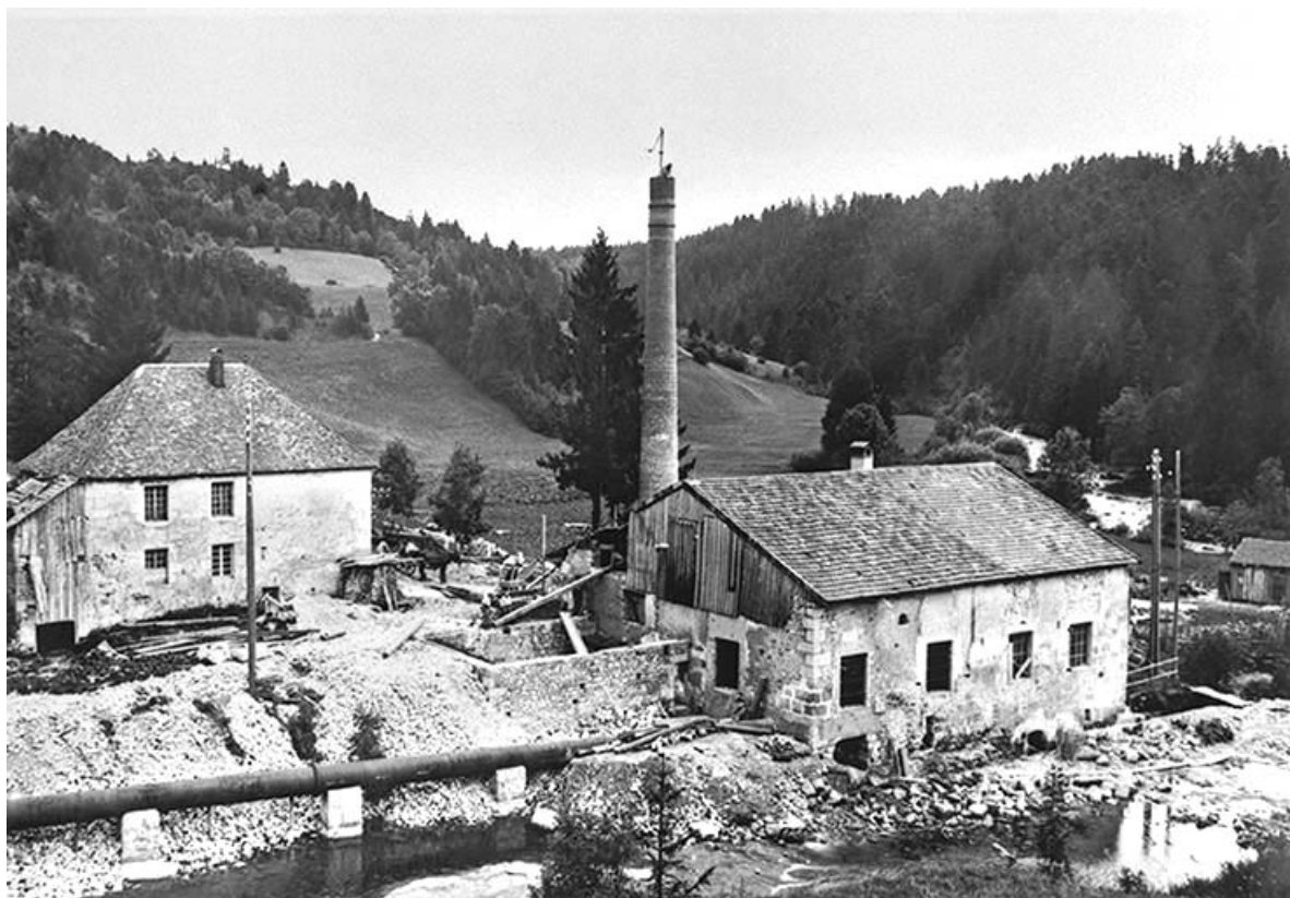
La centrale hydroélectrique de Bellefontaine.
