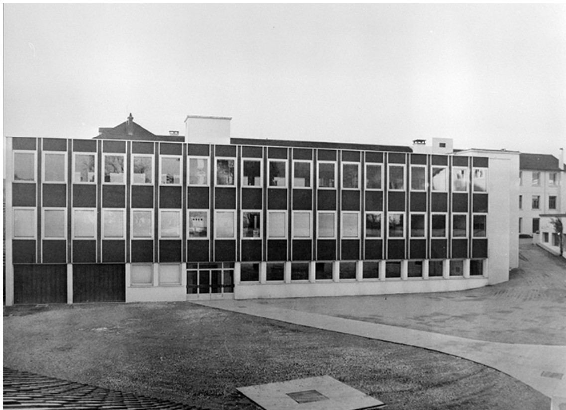
Atelier de fabrication construit en 1970. 39, Champagnole, 3 rue Baronne Delort
