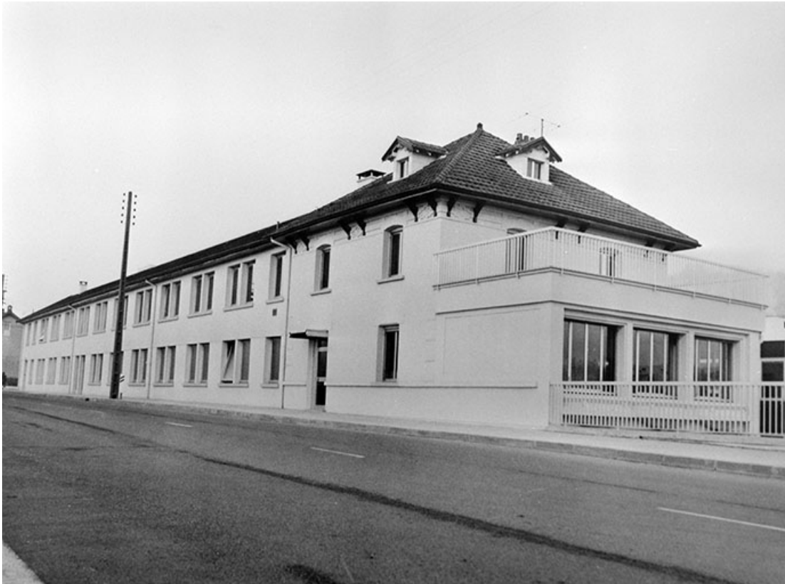
Atelier de fabrication et bureau depuis le sud-ouest.
