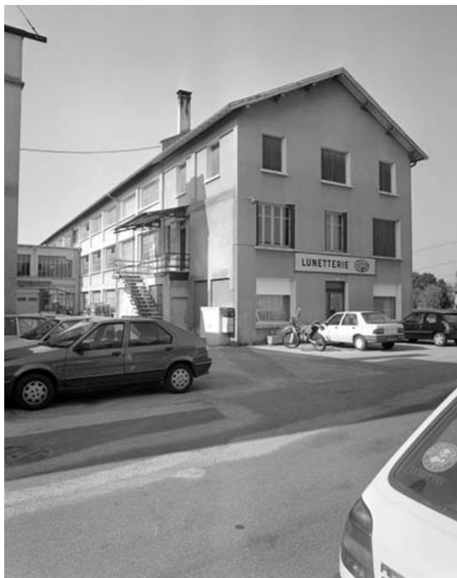
Bureau et atelier de fabrication ouest vus de trois quarts.
