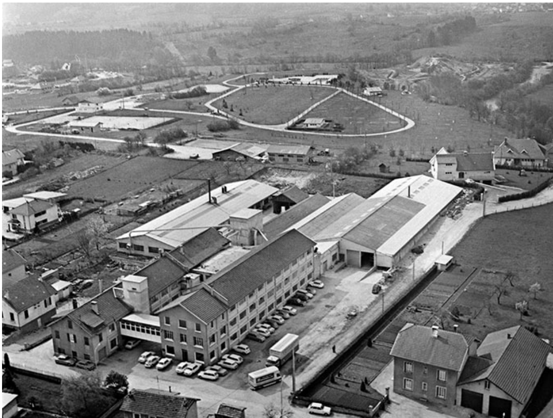
Vue aérienne depuis le nord.
