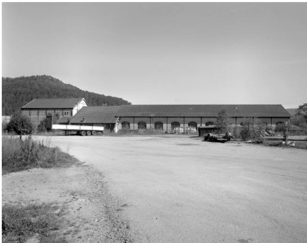
L'atelier de finition depuis l'ouest.
