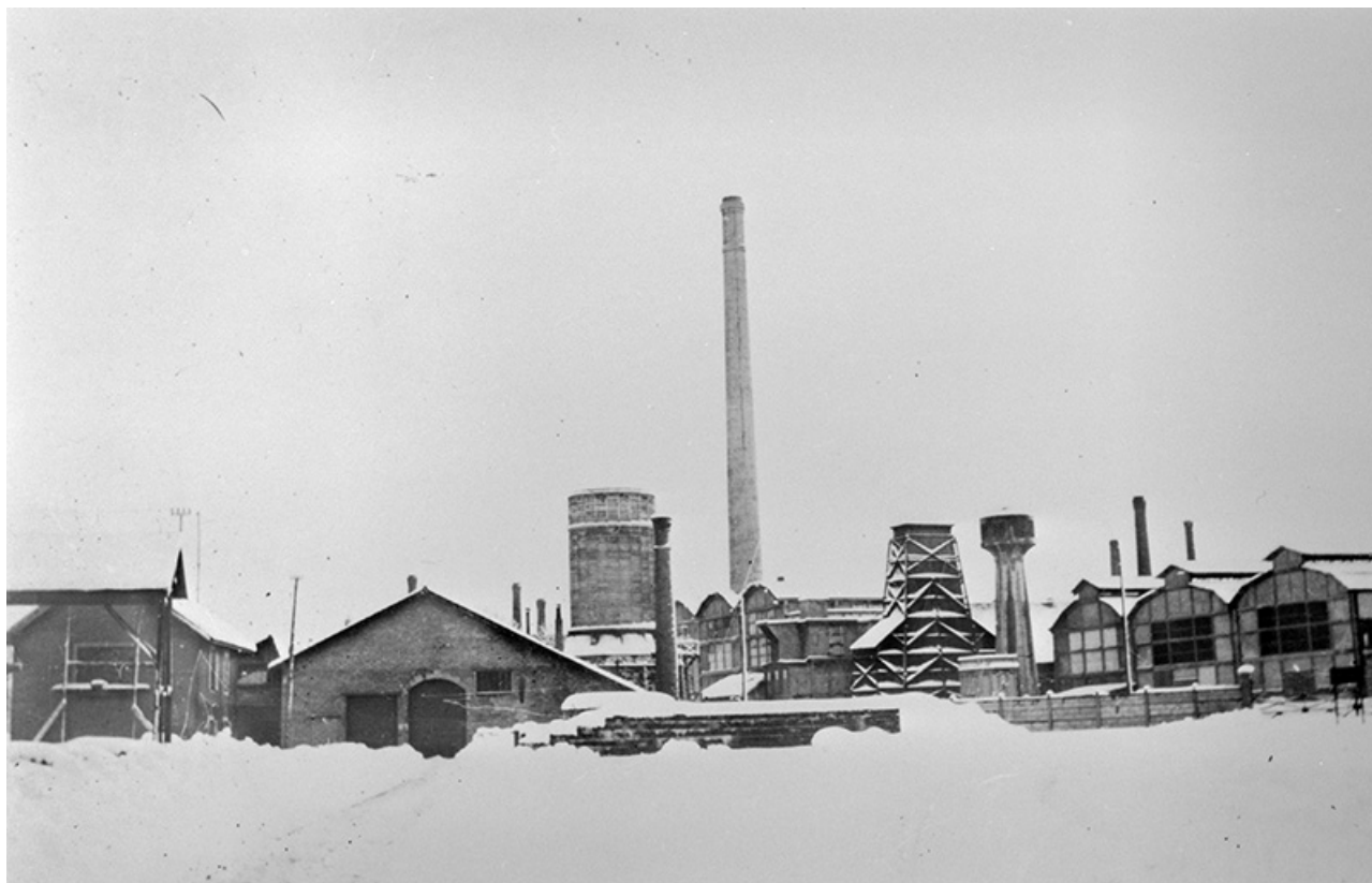
Vue d'ensemble des Aciéries depuis le nord.
