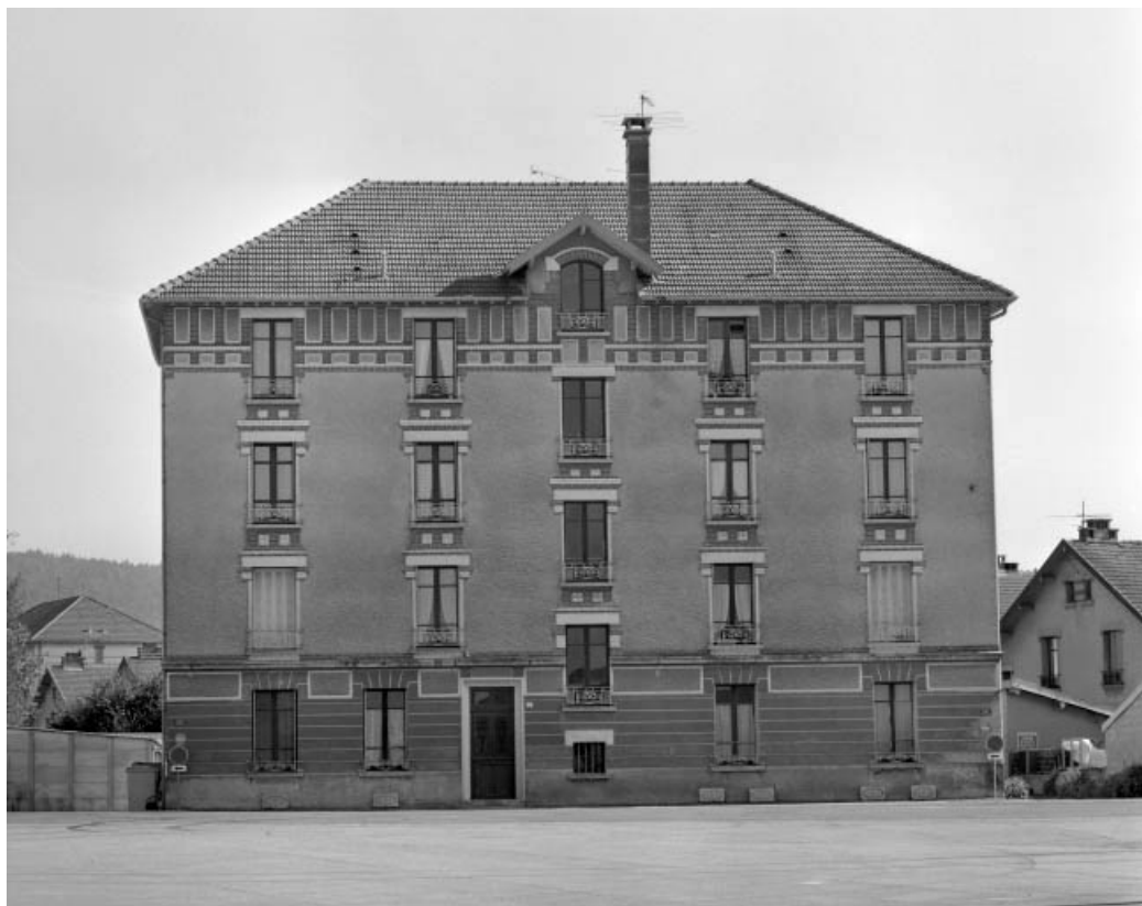
Façade antérieure d'un immeuble de la cité ouvrière.
