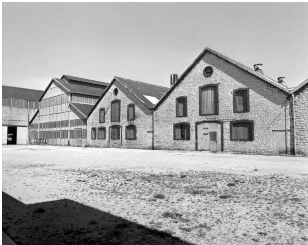
Les ateliers de l'ancienne forge depuis le sud.
