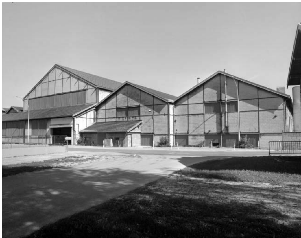
Pignons ouest de l'atelier de fabrication et de réparation.
