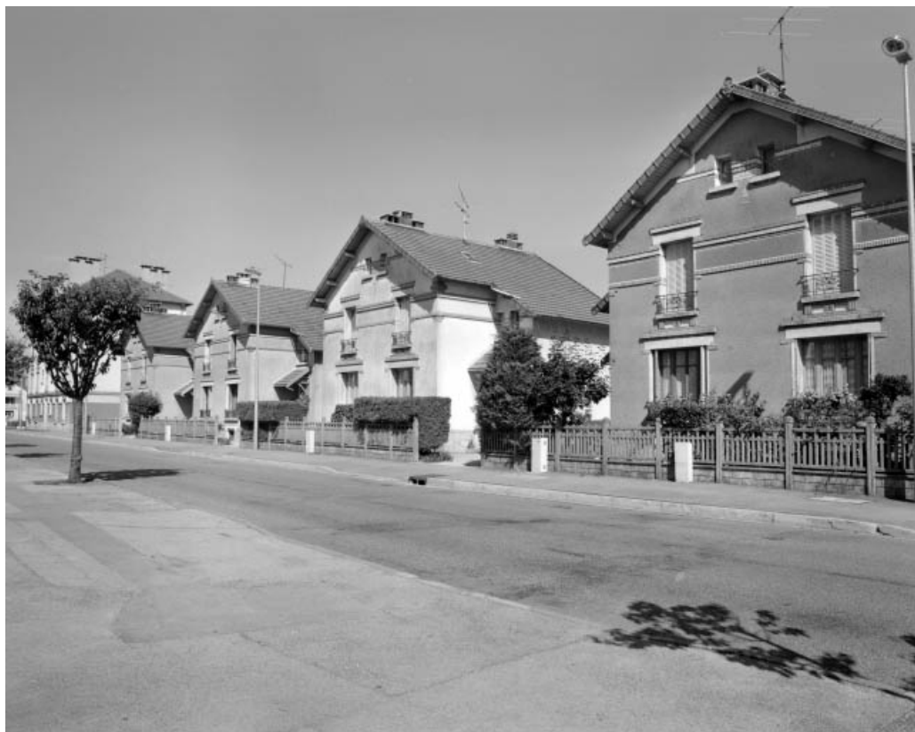
Cité ouvrière : logements doubles rue de la Liberté.
