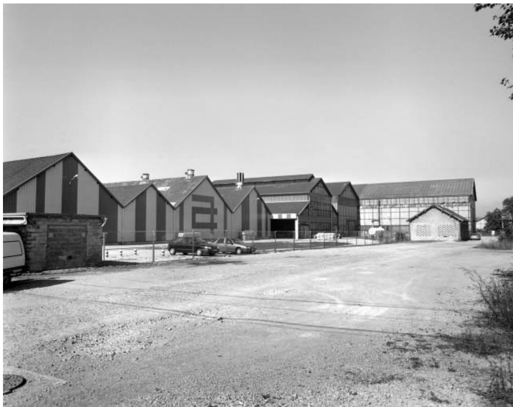
Façades postérieures des ateliers de l'ancienne forge.
