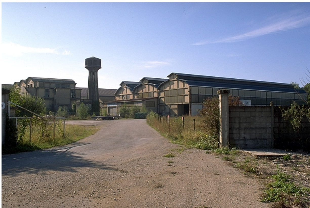
La centrale thermique, le château d'eau et l'ancienne fonderie.
