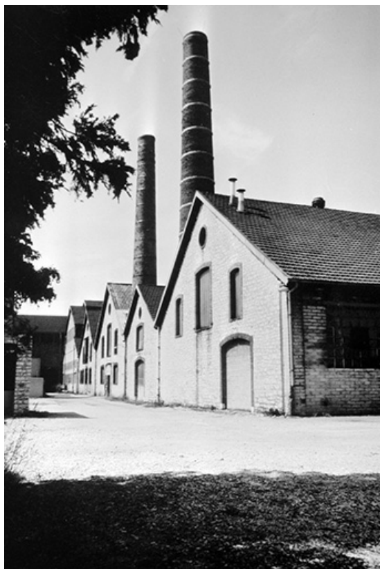
Façades sur cour du bâtiment du martelage ou ancienne forge.
