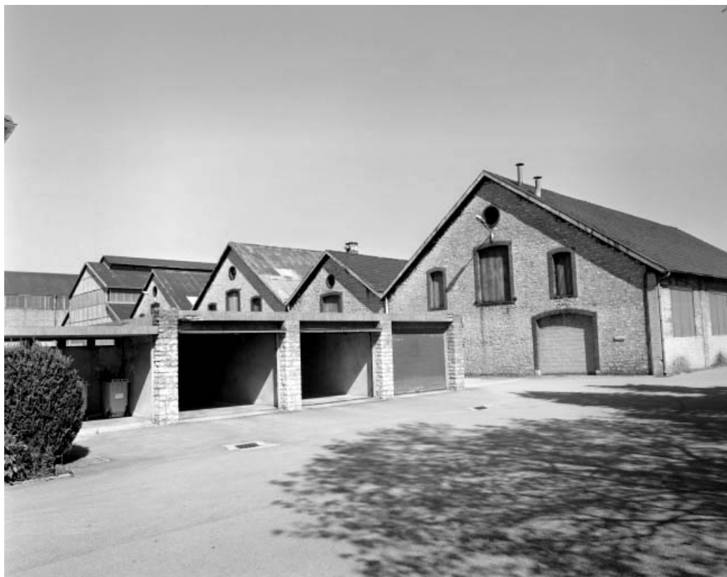
Pignons des ateliers de l'ancienne forge.
