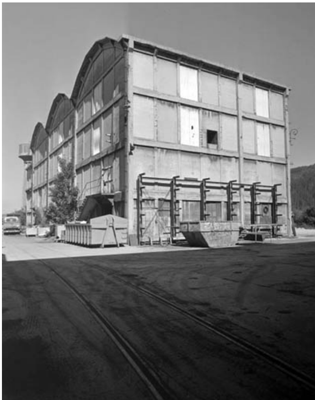
La centrale thermique vue de trois quarts.
