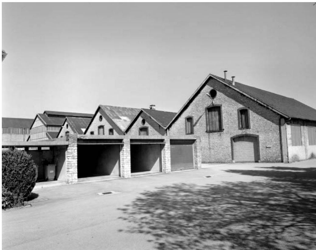
Pignons des ateliers de l'ancienne forge.
