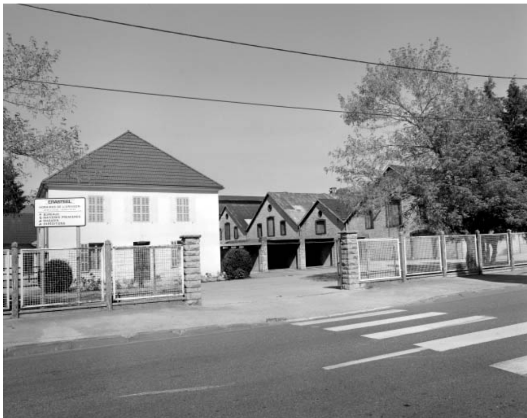
De gauche à droite : bureaux et ateliers de l'ancienne forge.
