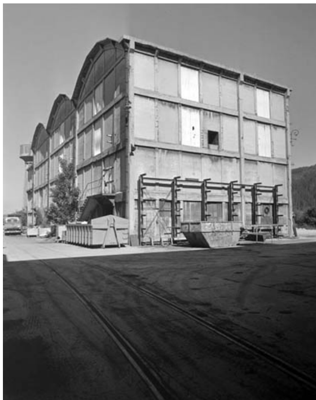
La centrale thermique vue de trois quarts.
