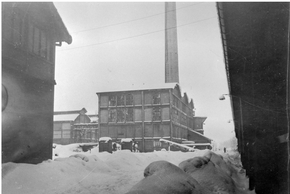
La centrale thermique depuis le sud-est.
