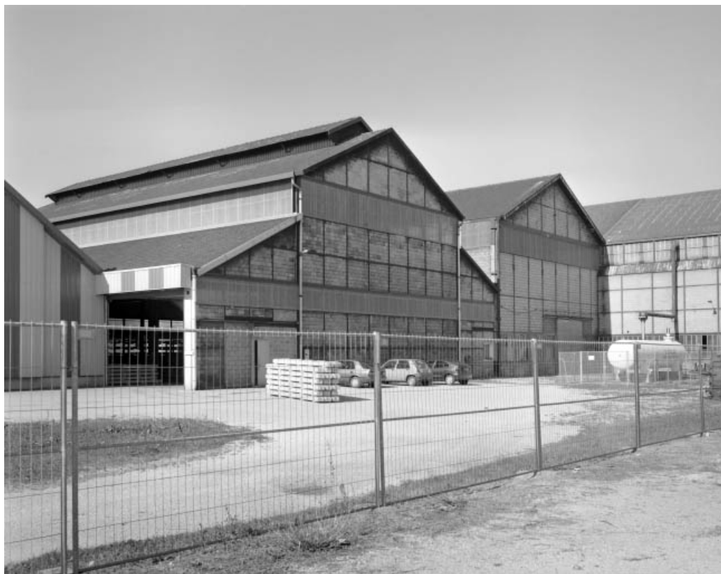
Façades postérieures de l'ancienne forge (actuellement magasin d'expédition). 39, Champagnole, 23, 25 rue Clémenceau
