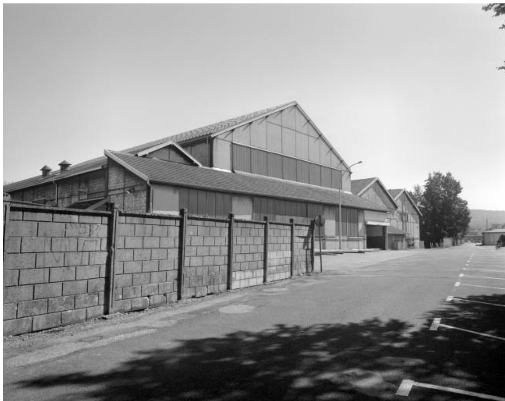
Façades postérieures de l'atelier de fabrication depuis la rue Ripotot.
