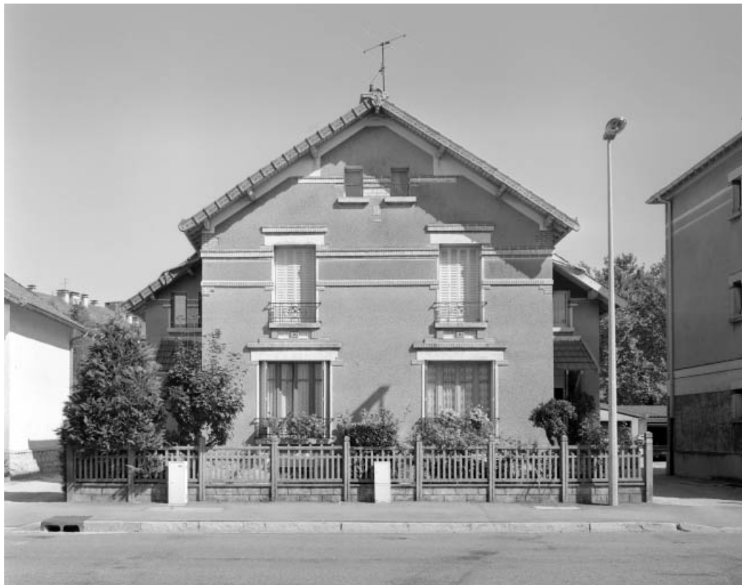
Façade antérieure d'un logement double (cadrage horizontal).
