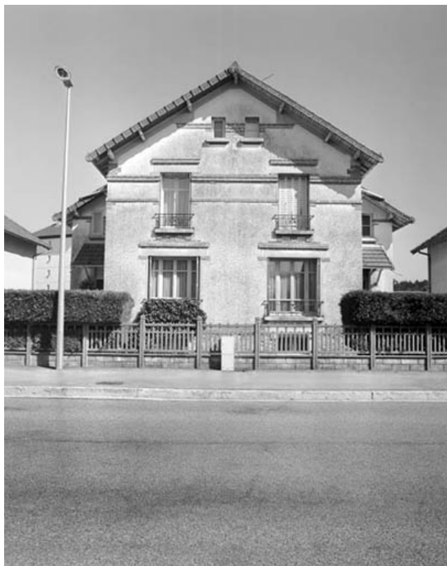
Façade antérieure d'un logement double (cadrage vertical).
