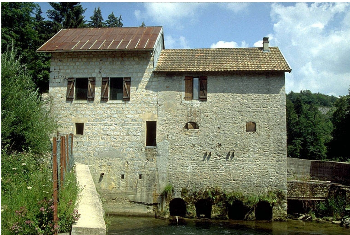
Façade latérale droite.
