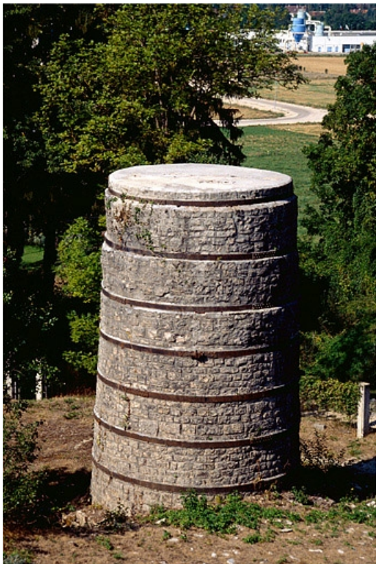
Vue plongeante sur le four à chaux. 39, Champagnole chemin de Mont Rivel
