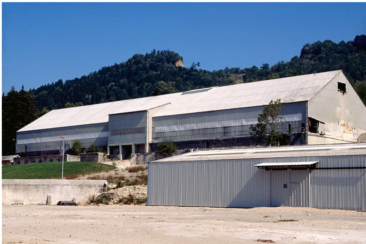
Hall de préhomogénéisation.
