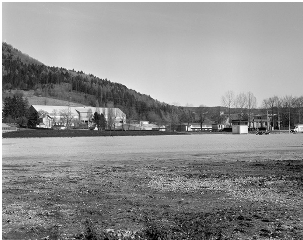
Vue d'ensemble depuis l'ouest.
