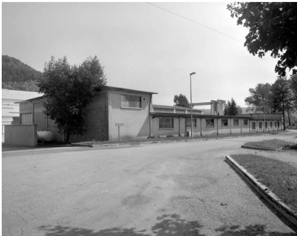
Façade ouest de l'atelier de réparation.
