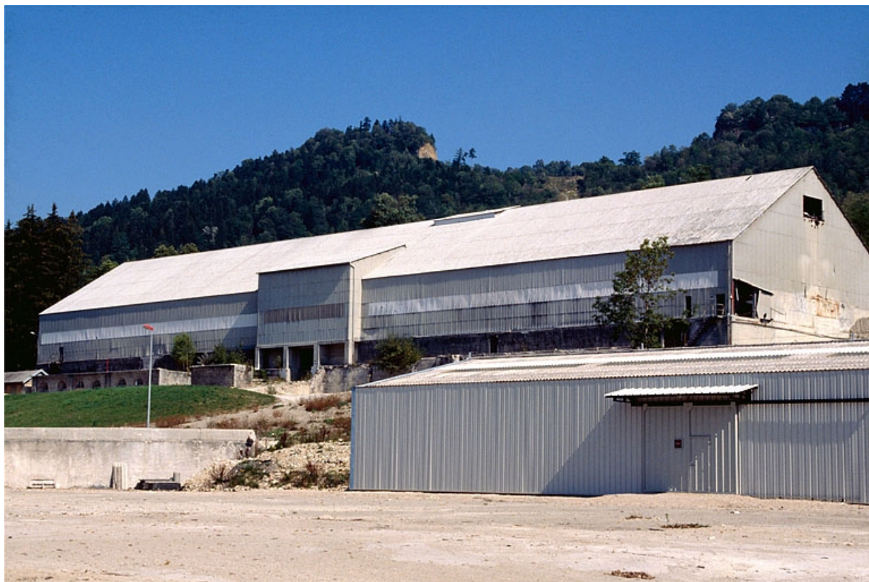
Hall de préhomogénéisation.
