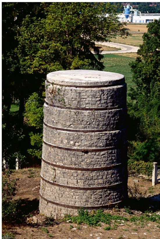
Vue plongeante sur le four à chaux. 39, Champagnole chemin de Mont Rivel
