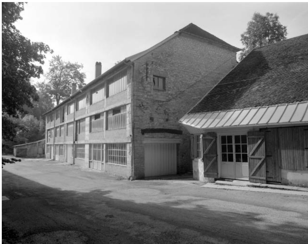
Atelier de fabrication et magasin industriel vus de trois quarts droit.
