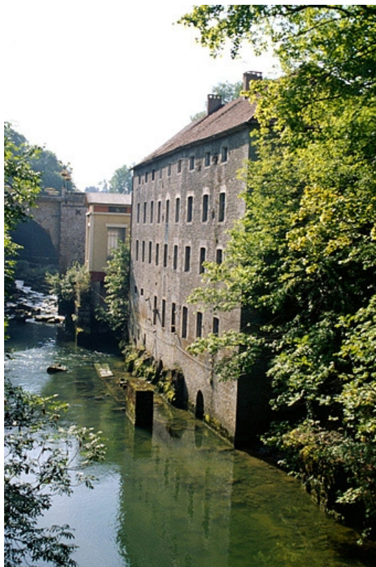
Élévation de l'atelier de fabrication depuis l'aval.
