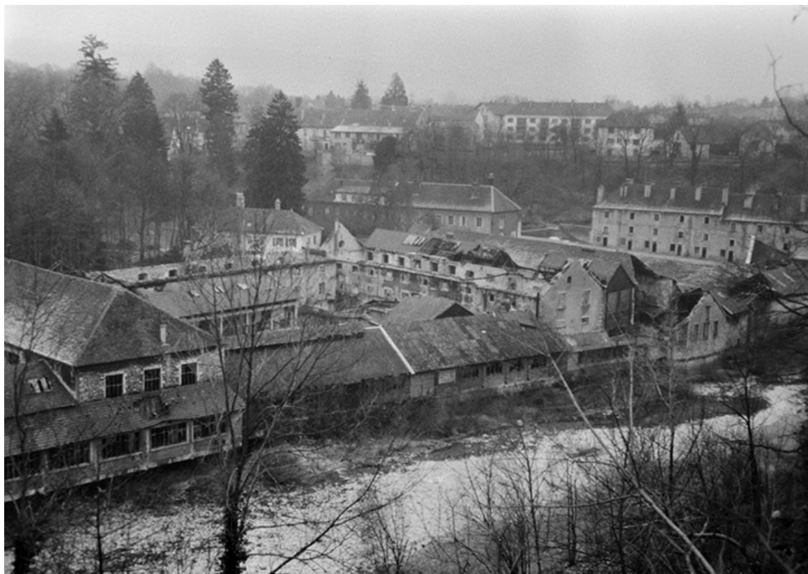
Vue d'ensemble depuis l'ouest après l'incendie de 1989.
