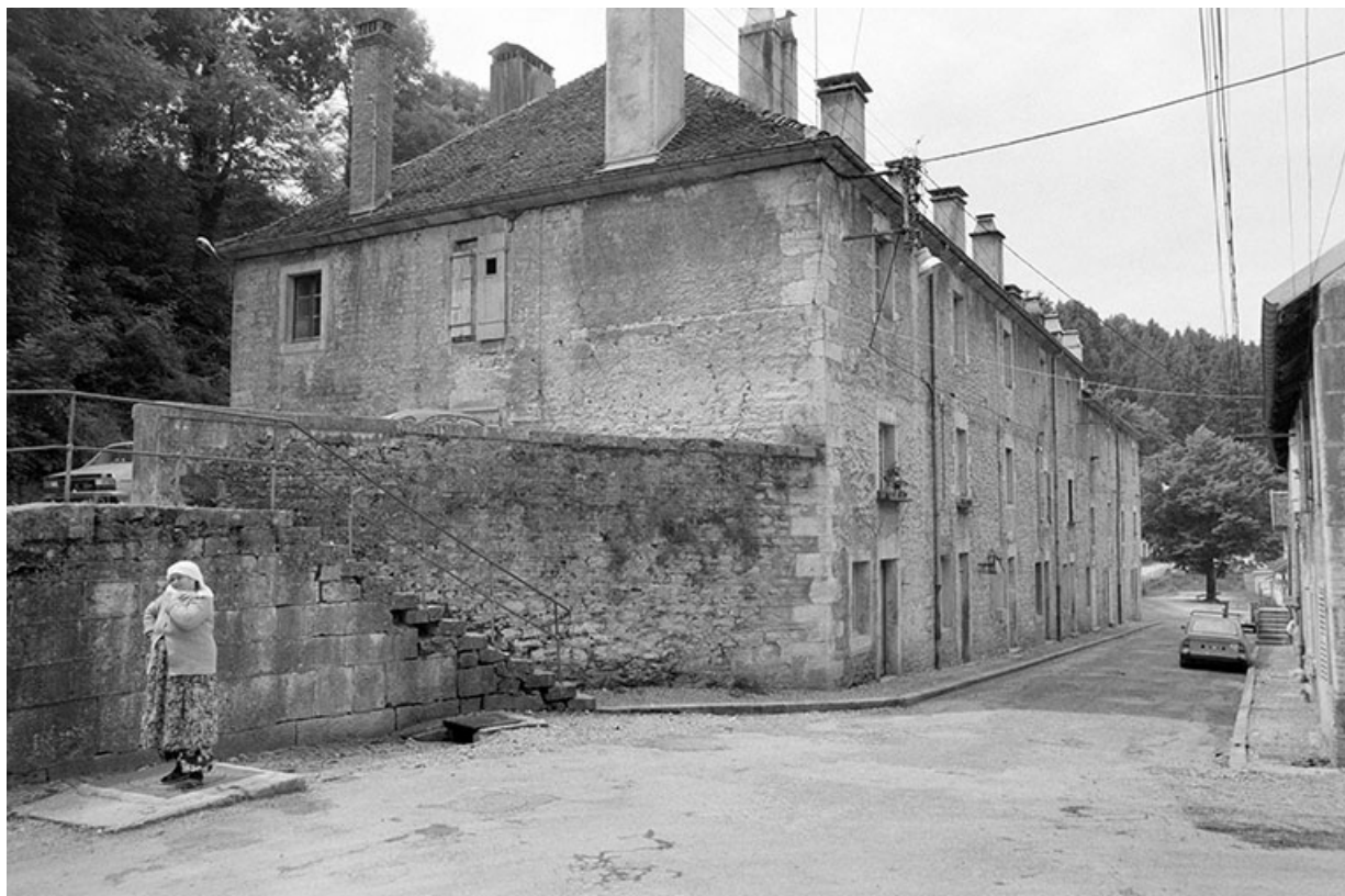
Logements d'ouvriers depuis la rue Adrien Muller en 1980.
