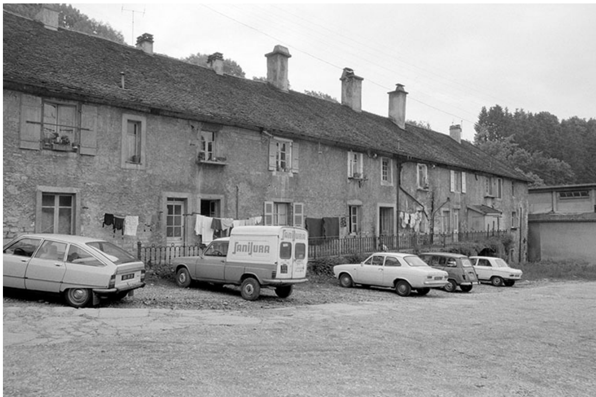
Logements d'ouvriers en 1980 : façade sur cour.
