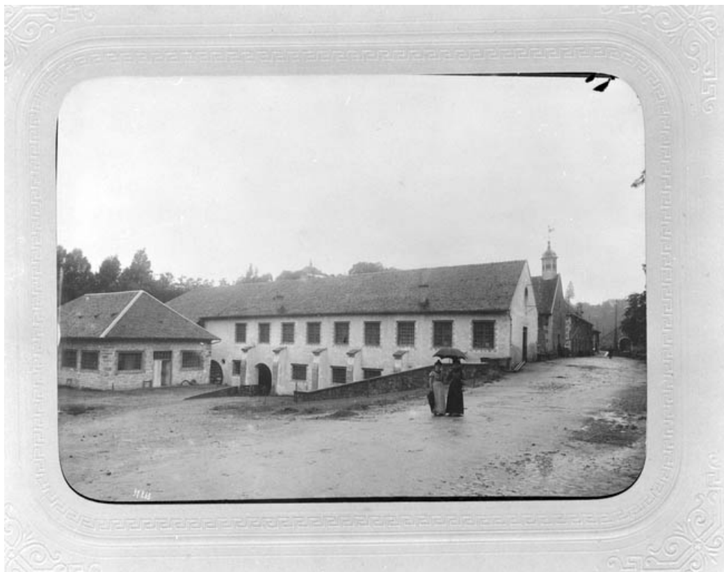
Bâtiments industriels à la fin du 19e siècle : scierie, vieille forge et tréfilerie.
