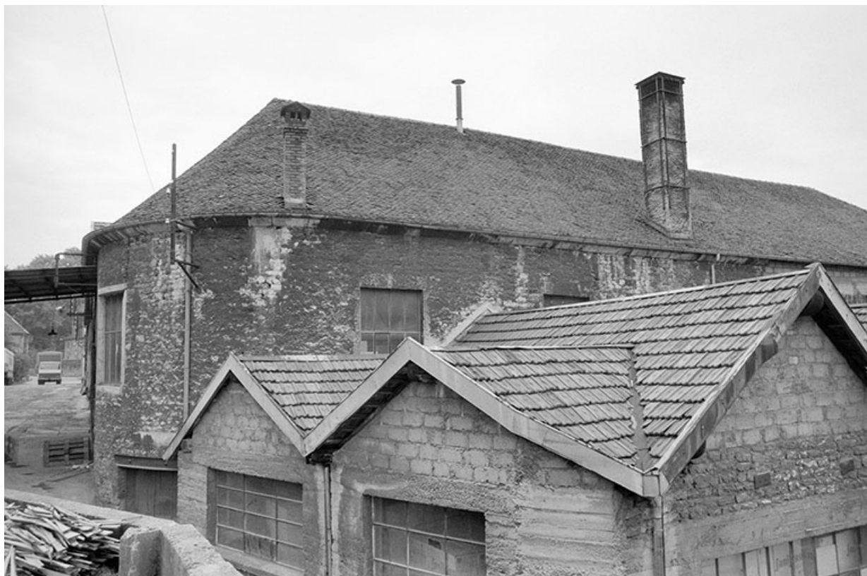
Extrémité est de l'atelier de forge en 1980.
