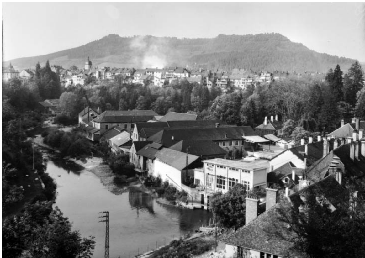
Vue d'ensemble depuis le sud-ouest. 39, Champagnole rue Adrien Muller
