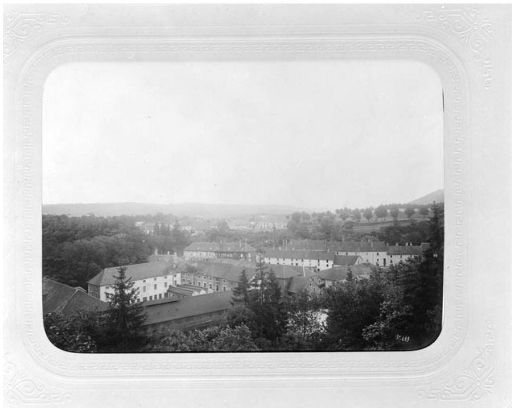
Vue d'ensemble depuis l'ouest, à la fin du 19e siècle.
