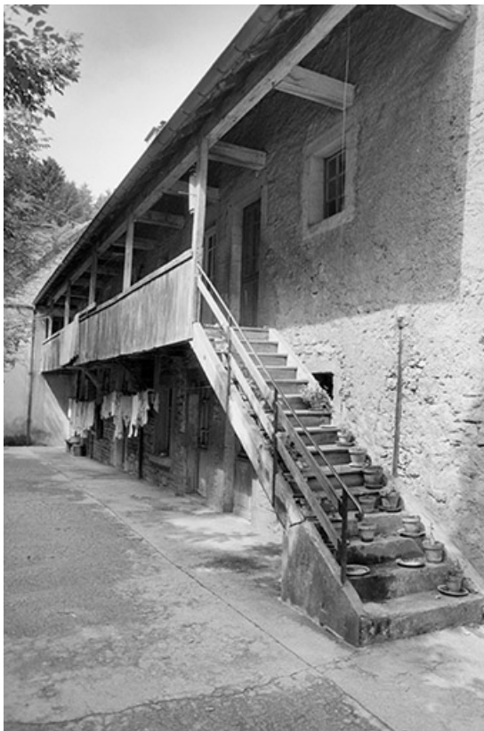
Façade postérieure d'un logement ouvrier en 1980. 39, Champagnole rue Adrien Muller
