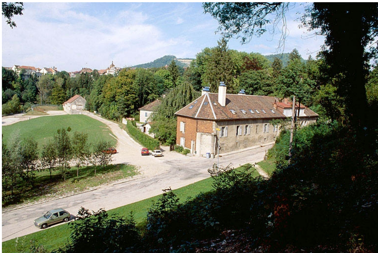
Vue d'ensemble depuis le sud. 39, Champagnole rue Adrien Muller
