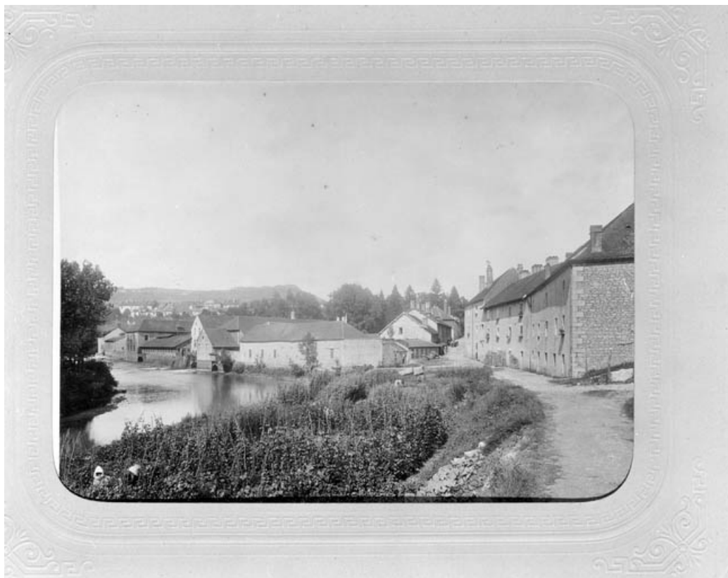
Usine et logements ouvriers depuis l'ouest, à la fin du 19e siècle.
