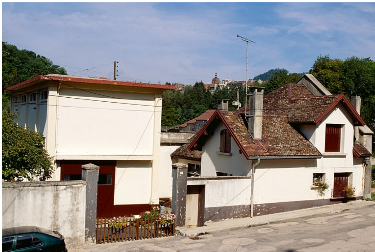
La centrale et le logement depuis le sud.
