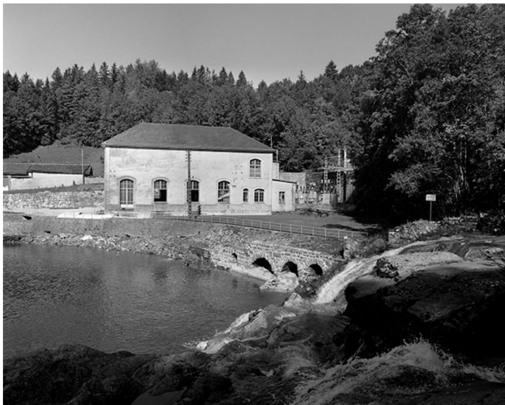
Vue d'ensemble de la centrale depuis la cascade.
