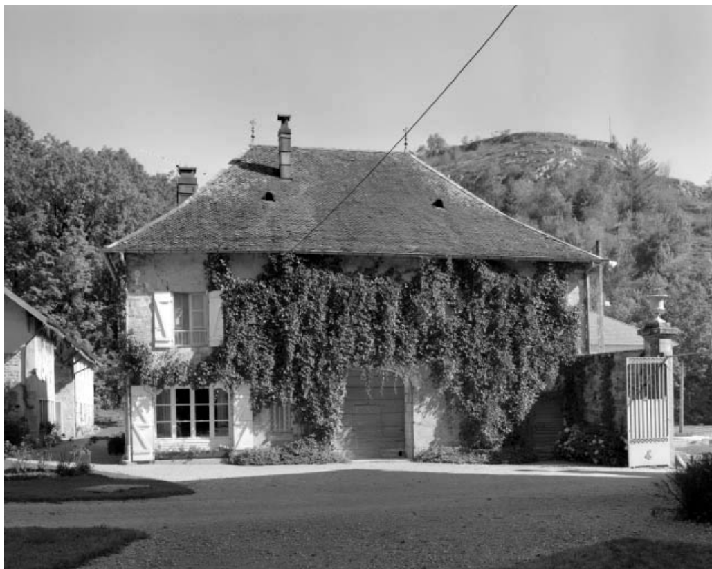
Façade antérieure du bâtiment abritant logement de domestiques et remise.
