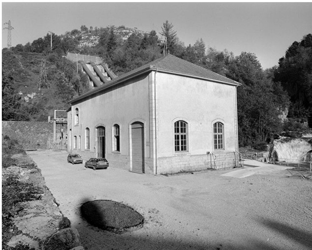
Centrale vue de trois quarts droite.
