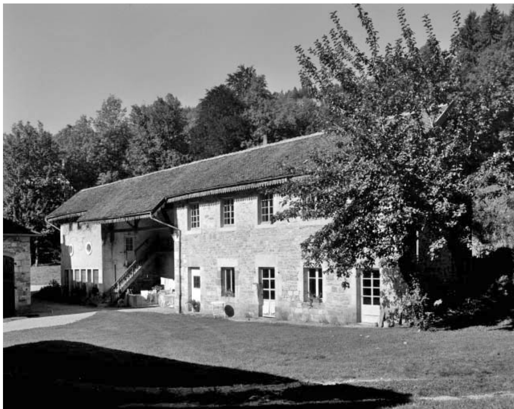
Bâtiment des communs vu de trois quarts droite.
