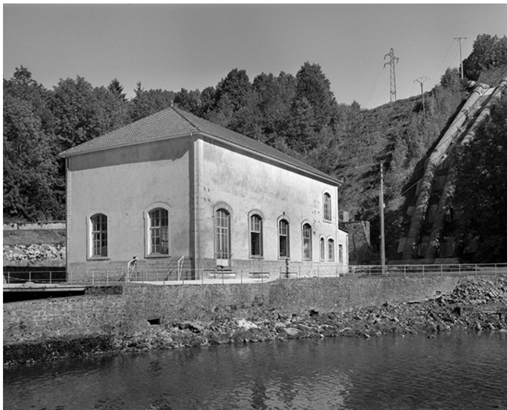
Façade postérieure de la centrale, vue de trois quarts gauche.
