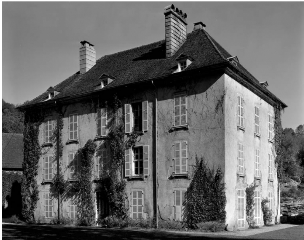
Façade postérieure du logement patronal, vue de trois quarts droite. 39, Bourg-de-Sirod, lieudit : les Forges
