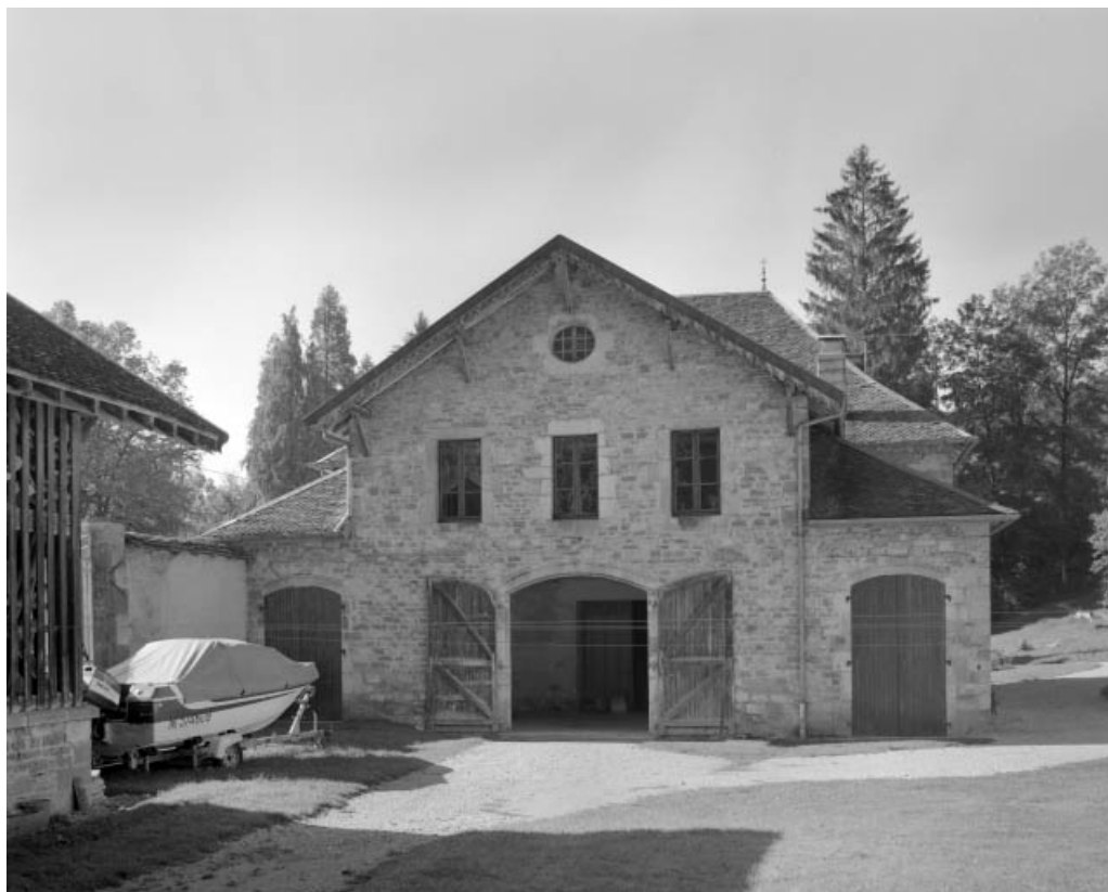
Façade postérieure du bâtiment abritant logement de domestiques et remise.
