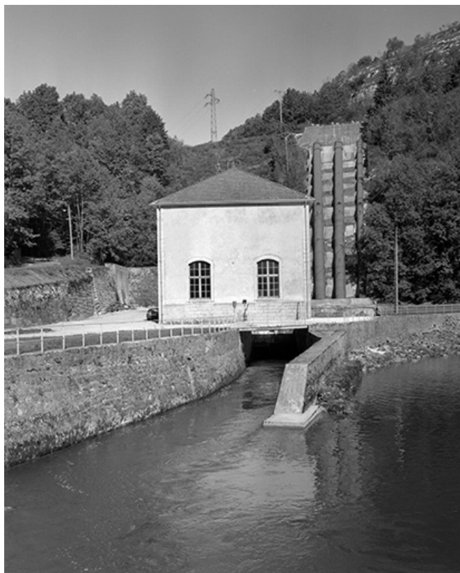
Façade latérale droite de la centrale et canal de fuite.
