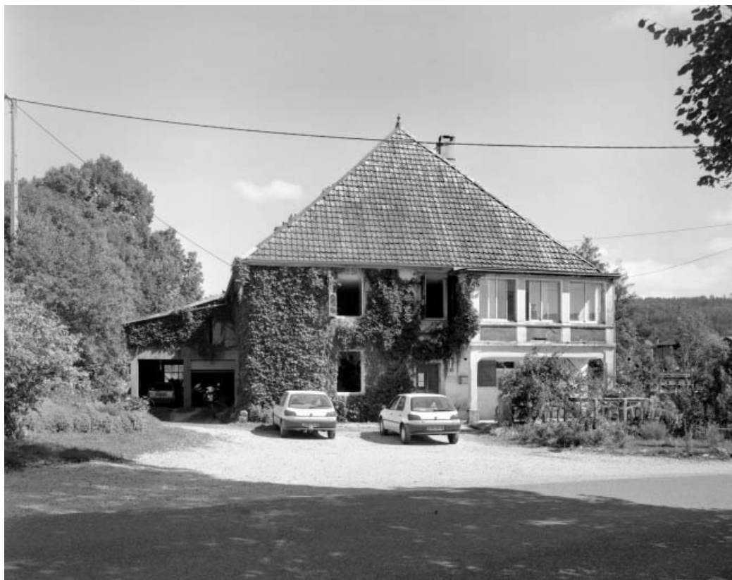
Façade ouest du logement.
