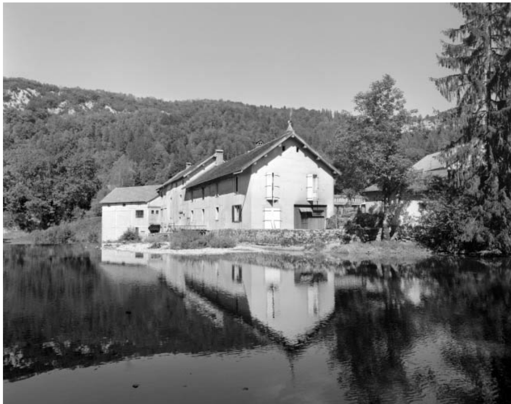
Vue d'ensemble depuis l'amont.
