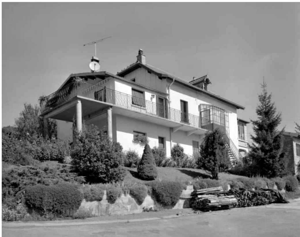
Vue en contre plongée du logement patronal.
