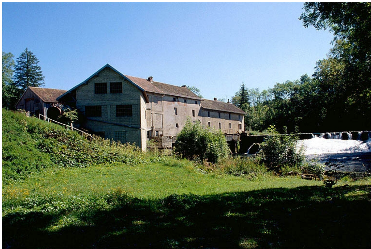
Façades postérieures vues de trois quarts gauche.
