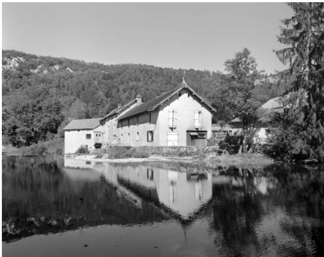
Vue d'ensemble depuis l'amont.
