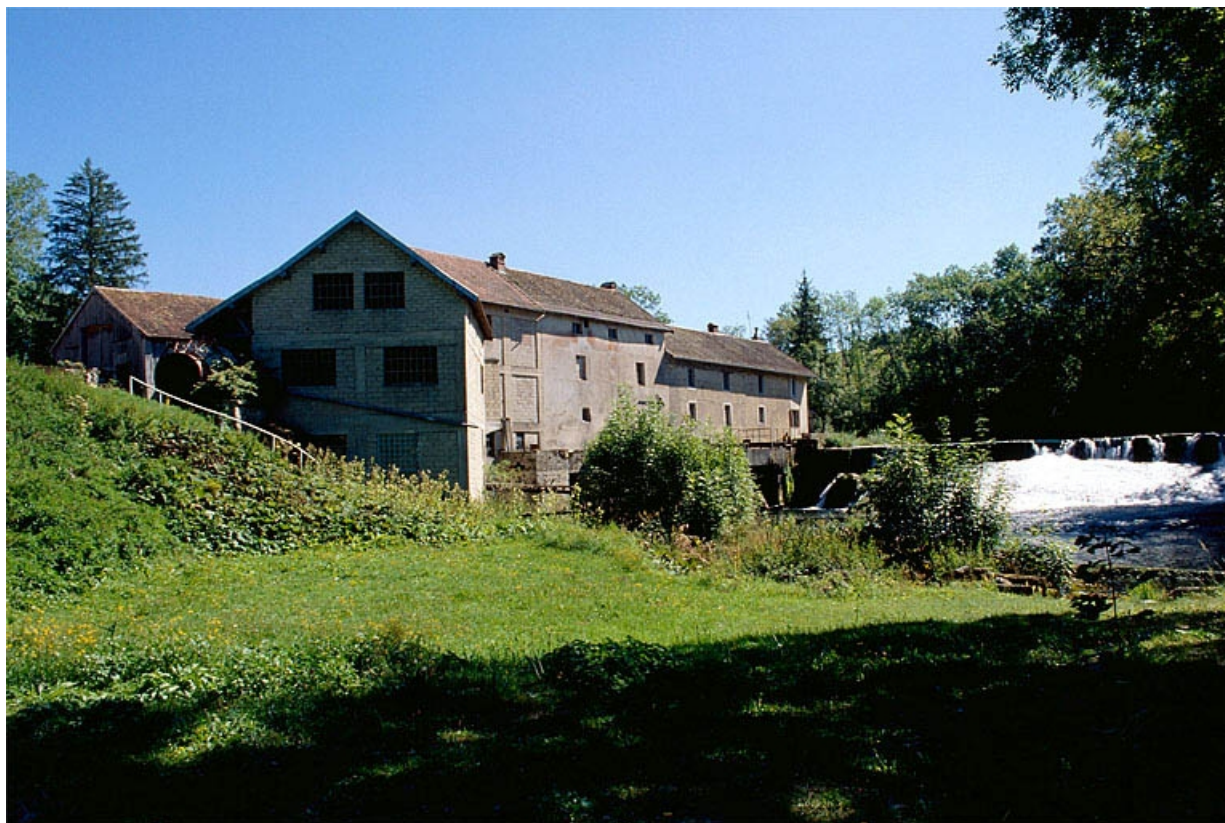
Façades postérieures vues de trois quarts gauche.
