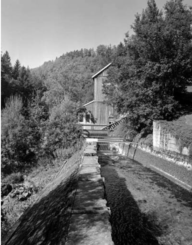
Canal d'amenée de la centrale hydroélectrique.
