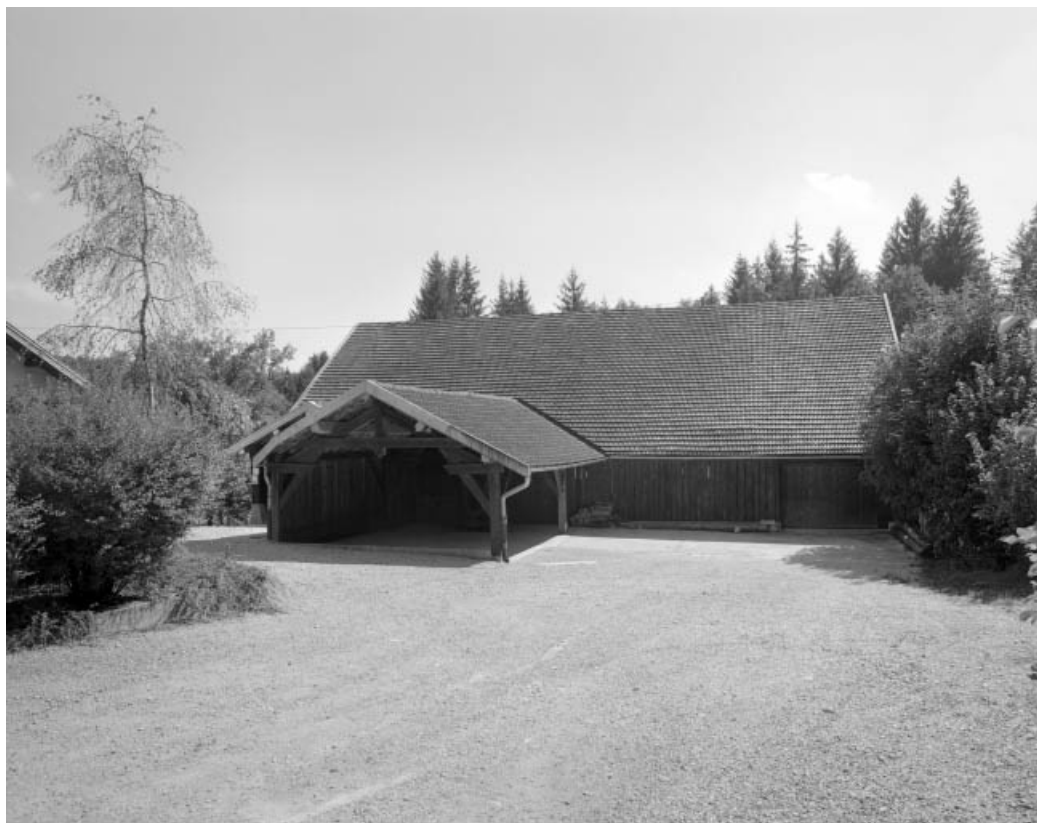
Façade nord de l'atelier de fabrication.
