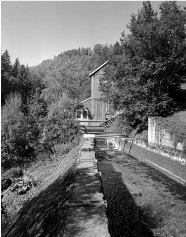
Canal d'amenée de la centrale hydroélectrique.
